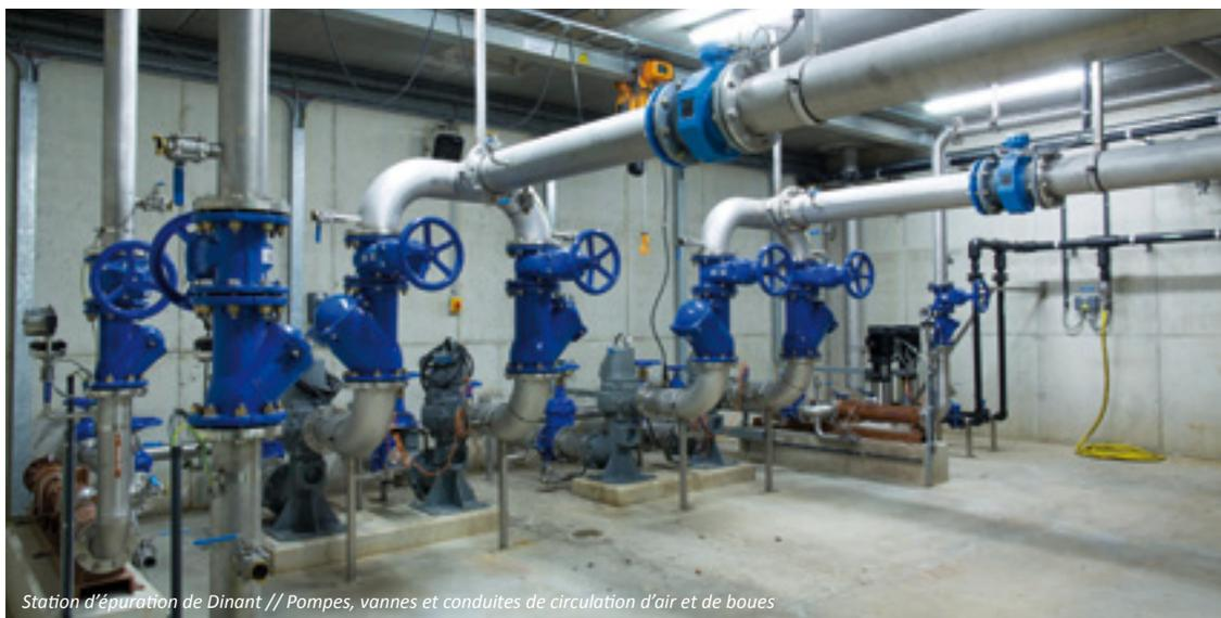
Station d'épuration de Dinant // Pompes, vannes et conduites de circulation d'air et de boues
