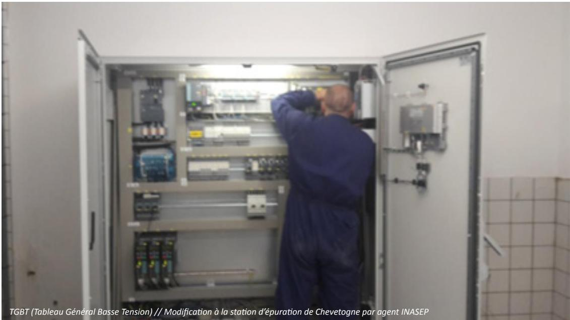
TGBT (Tableau Général Basse Tension) // Modification à la station d'épuration de Chevetogne par agent INASEP
