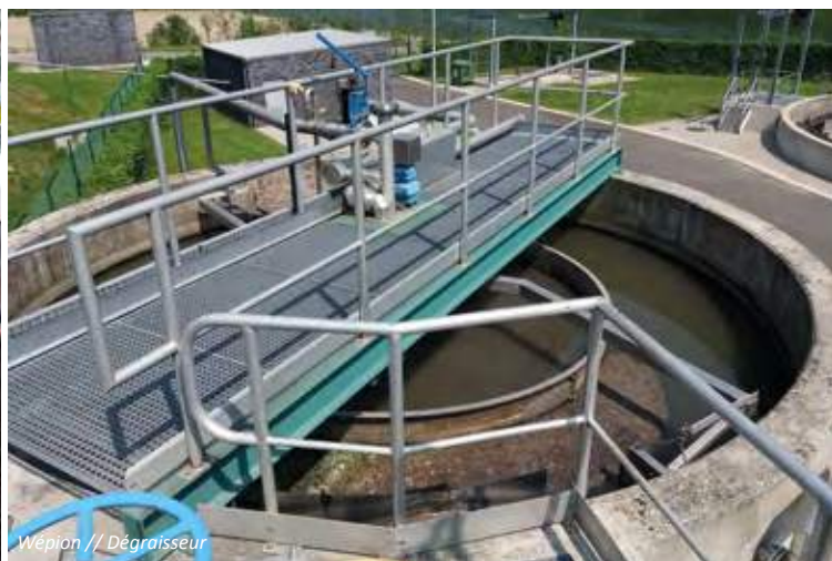
Mornimont // Sables récupérés en conteneur de l'unité de dessablage
