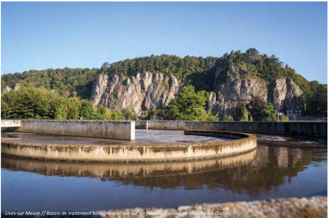
Vresse-sur-Semois // Station par ultrafiltration intégrée au paysage grâce à une structure typique des anciens hagards à tabac locaux
