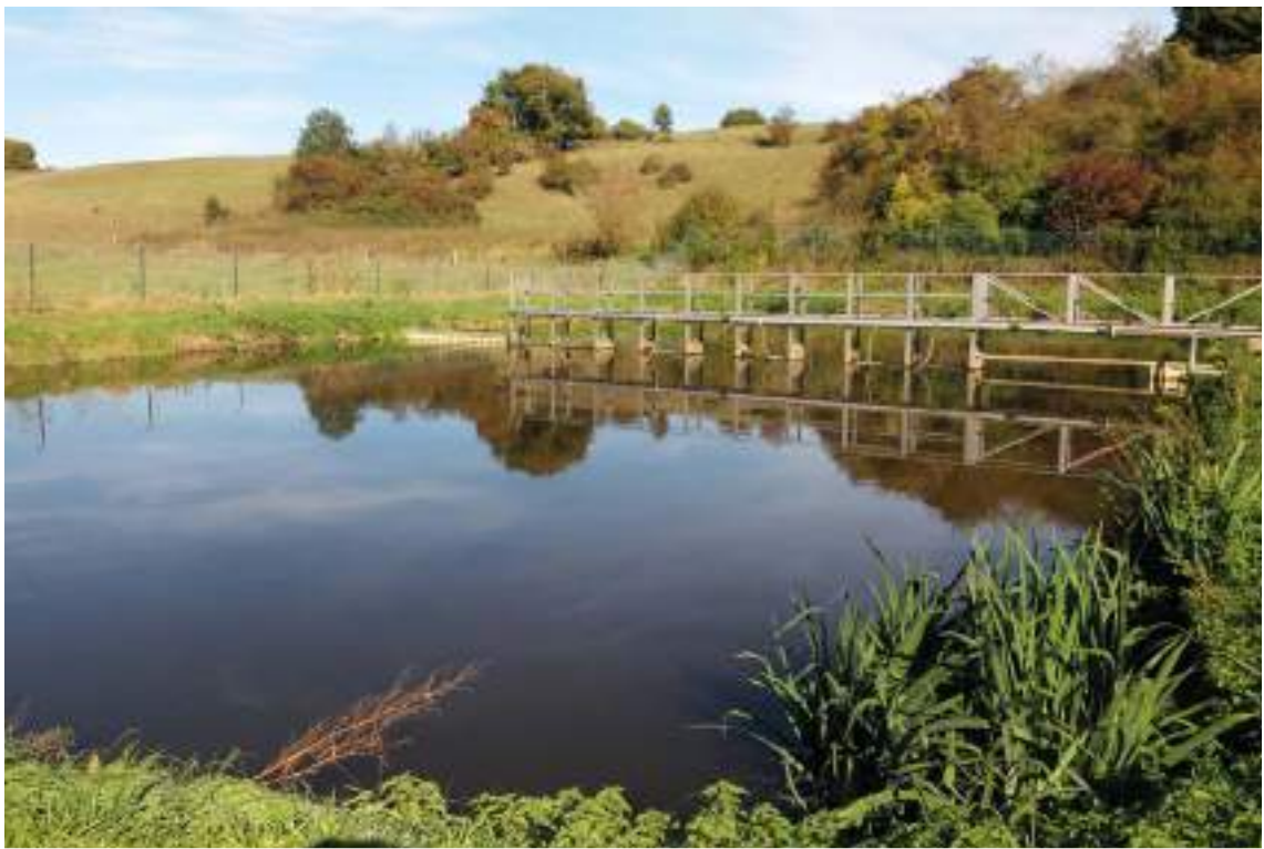
Falaën // Station d'épuration par lagunage
