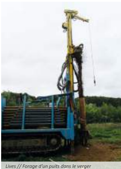
Lives // Forage d'un puits dans le verger
