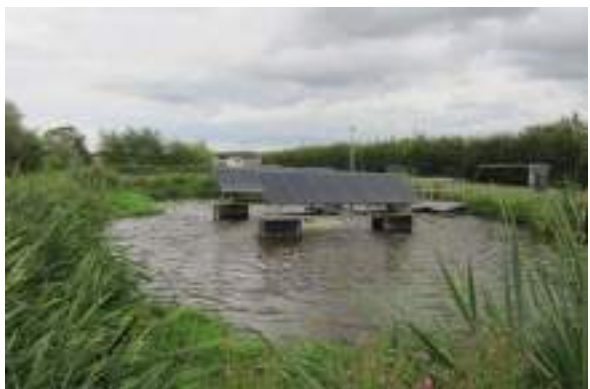
Sorée // Turbine d'aération alimentée par panneaux solaires
