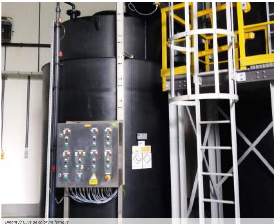
Dinant // Cuve de chlorure ferrique
