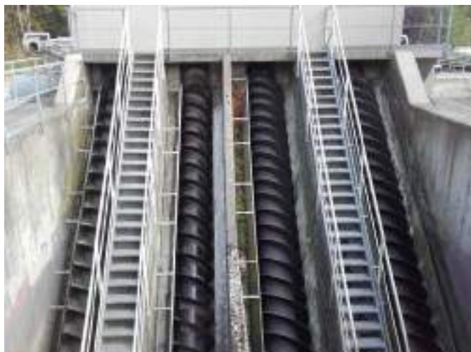
Corroy-le-Château // Vis de relevage
