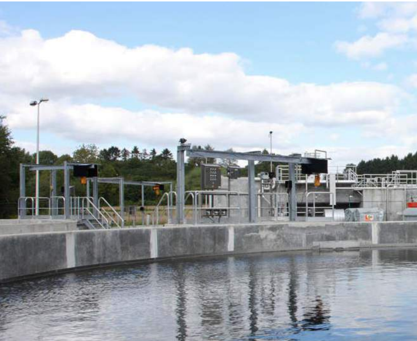
Saint-Martin // Station d'épuration
