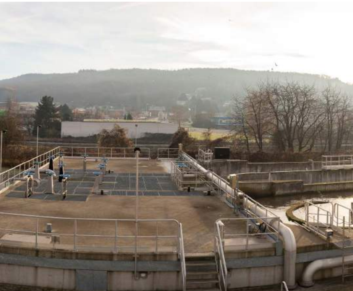
Floreffe // Station d'épuration
