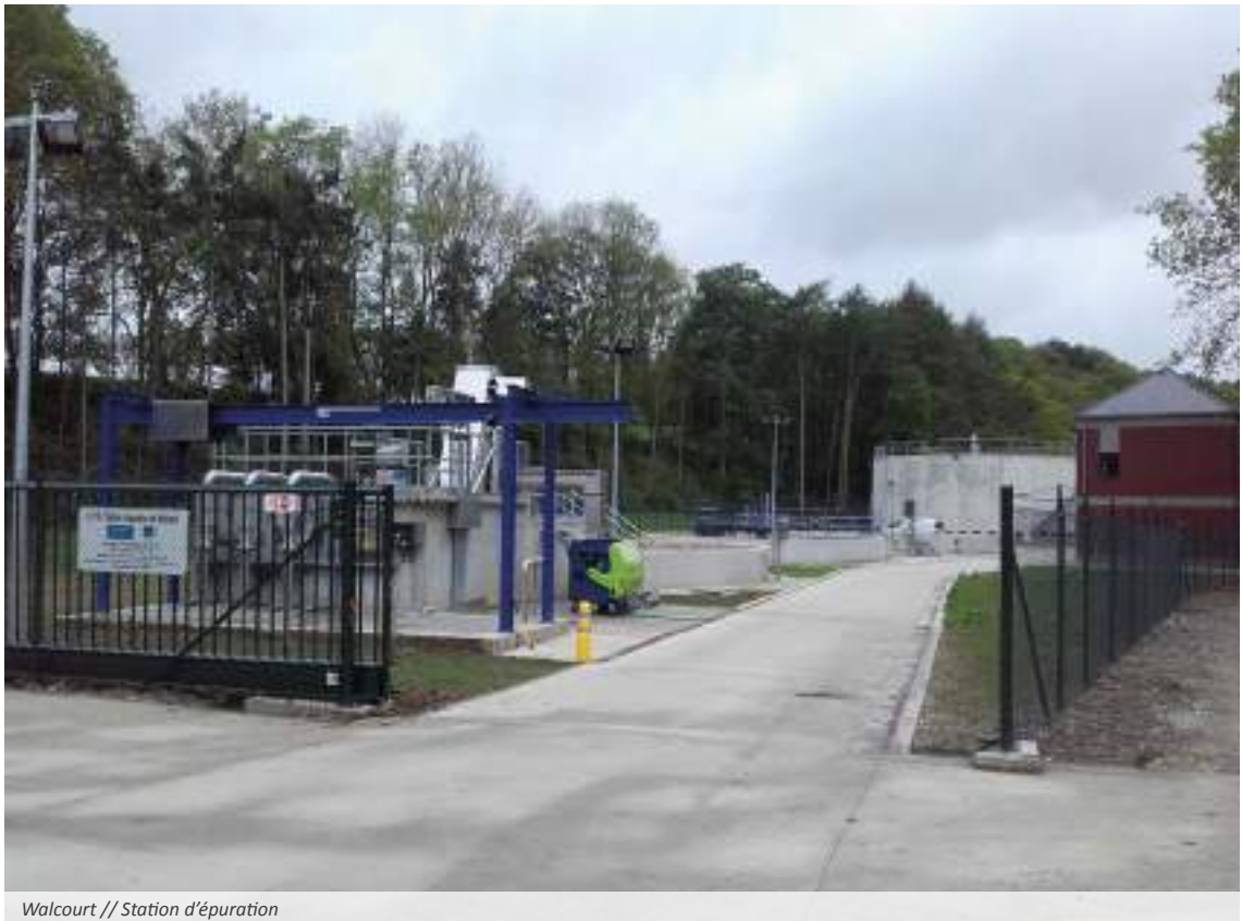
Walcourt // Station d'épuration
