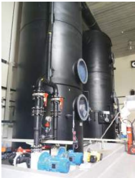
Dinant // Tours de désodorisation
