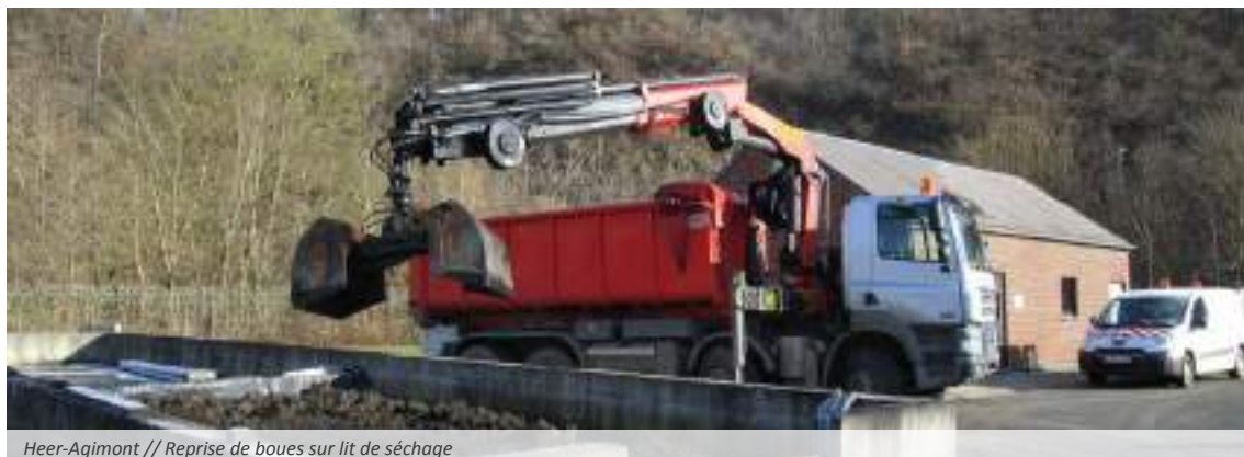
Heer-Agimont // Reprise de boues sur lit de séchage
