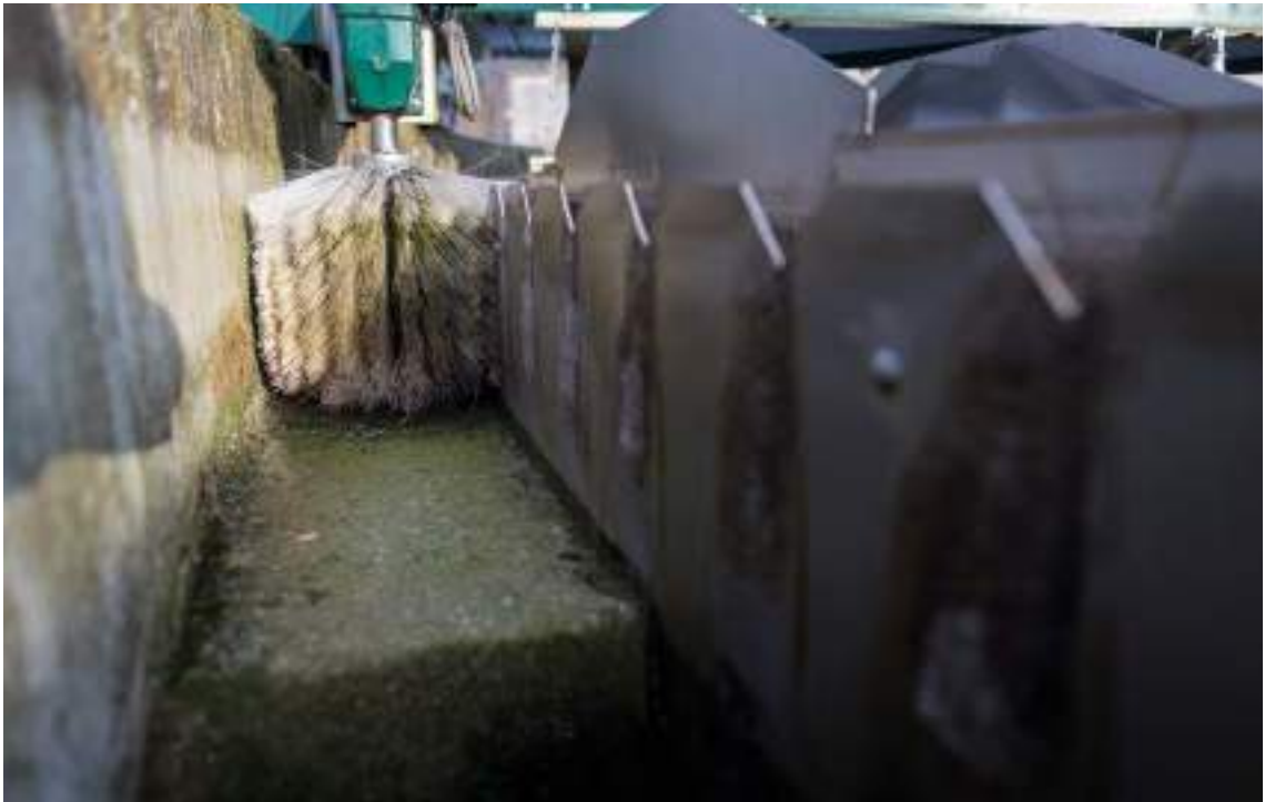
Florefe // Nettoyage de la goulotte du clarificateur
