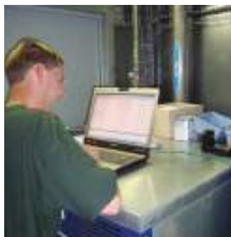
Vresse // Automatisation - Intervention sur le programme de conduite
