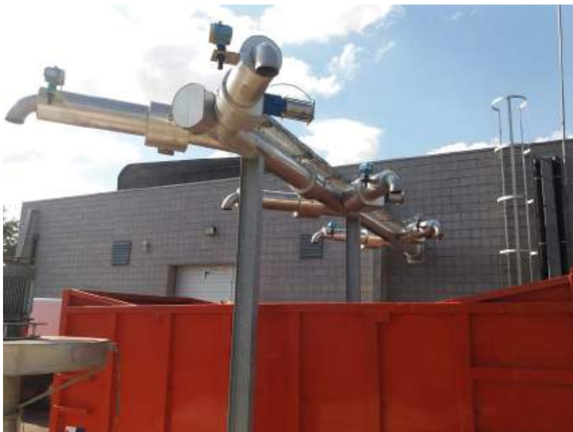
Mariembourg // Conteneur et registres de distribution des boues déshydratées
