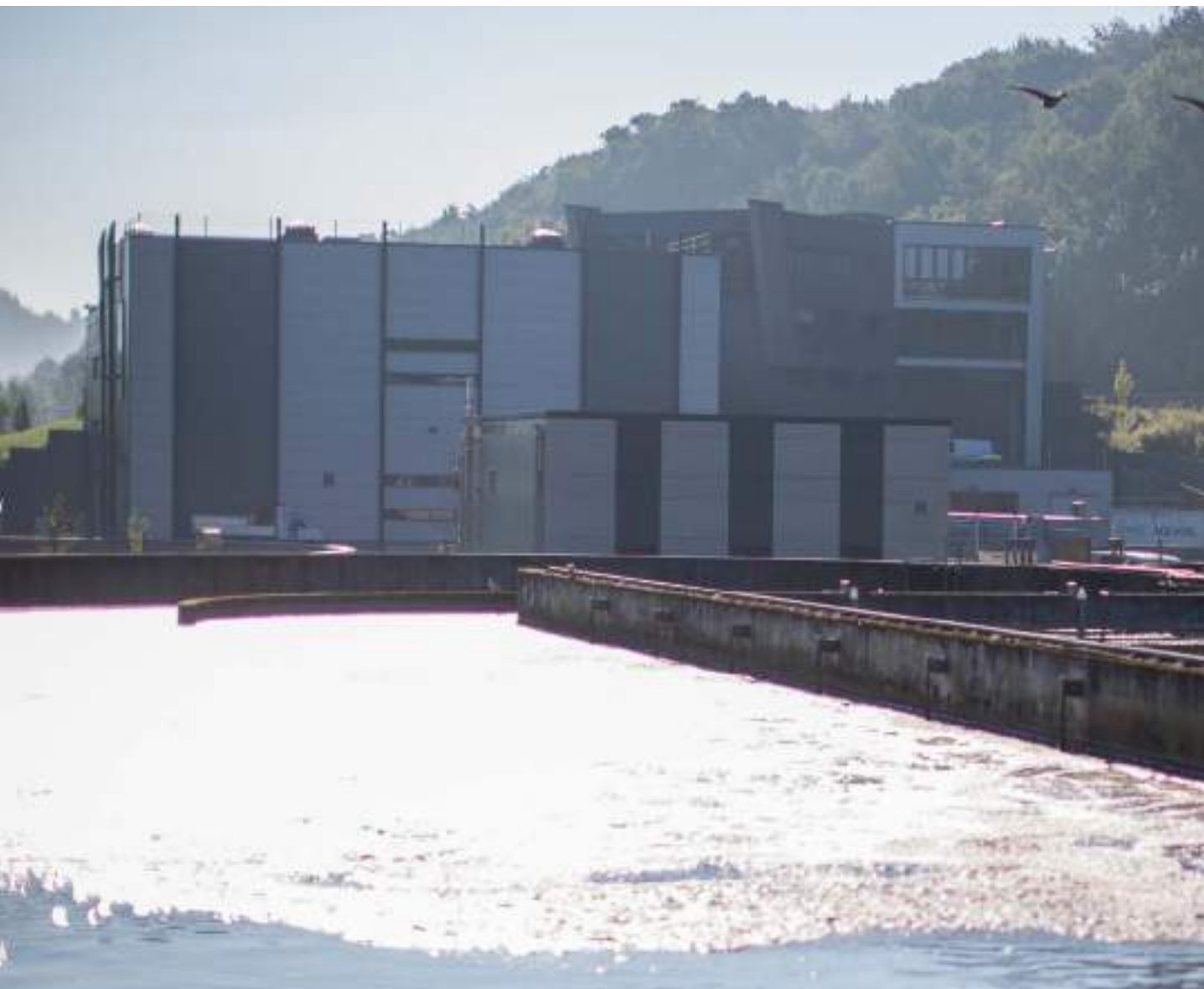
Lives-sur-Meuse // Station d'épuration
