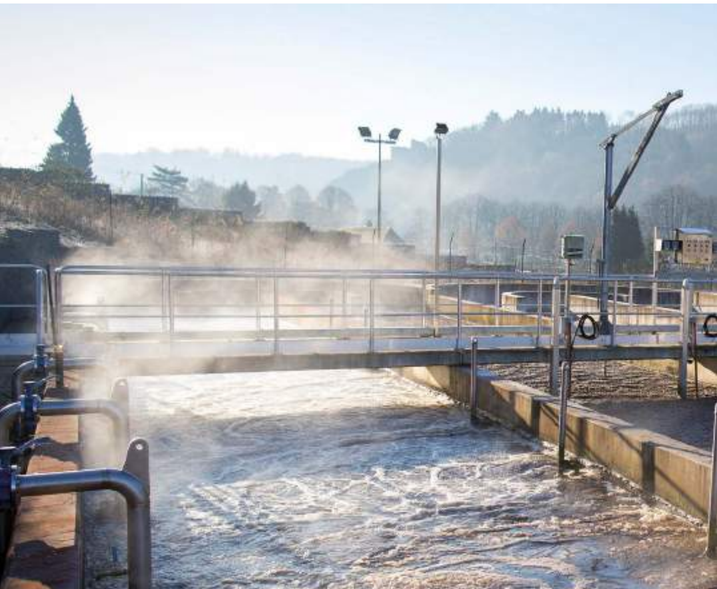
Dinant // Station d'épuration
