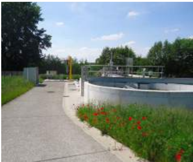
Pontillas Gochenée // Nouvelle station d'épuration 2020
