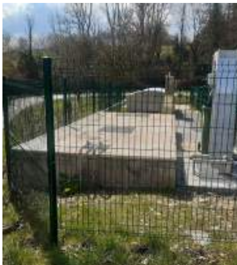
Herhet // Nouvelle station d'épuration 2021
