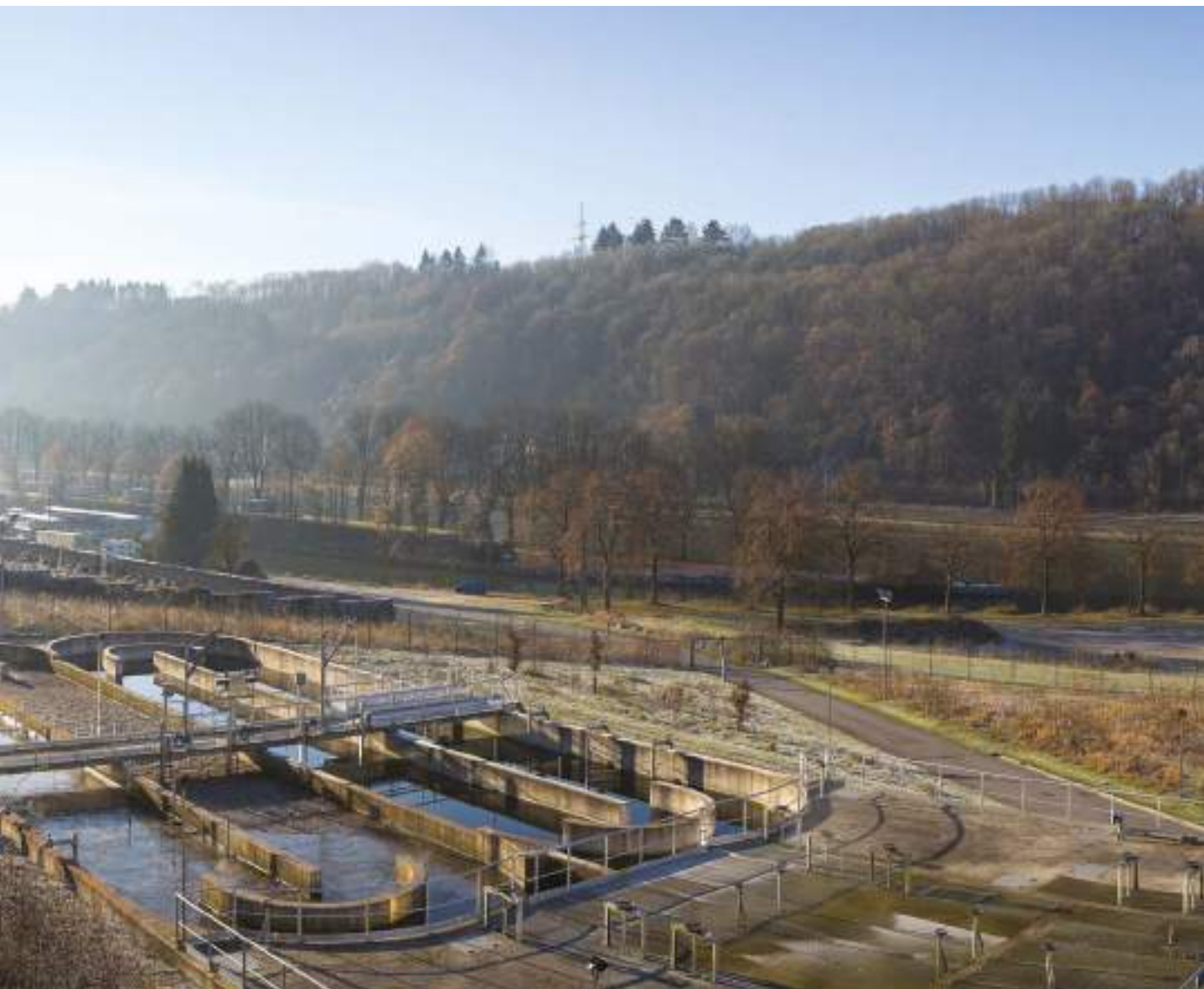
Dinant // Station d'épuration
