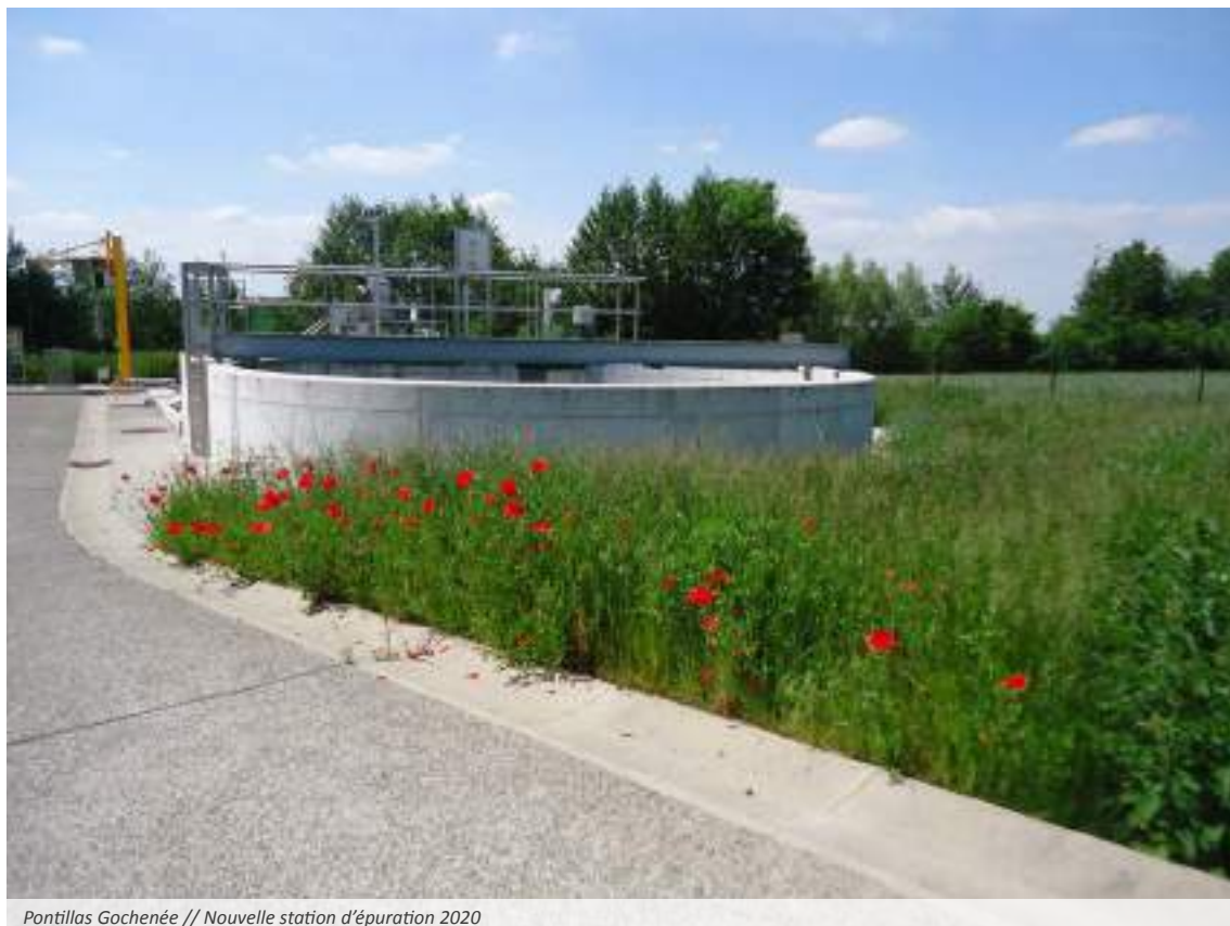
Pontillas Gochenée // Nouvelle station d'épuration 2020
