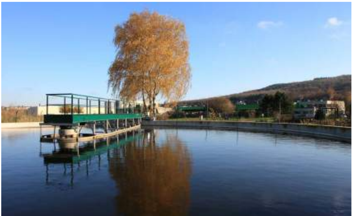
Floeffe // Décanteur secondaire (eaux traitées avant rejet)
