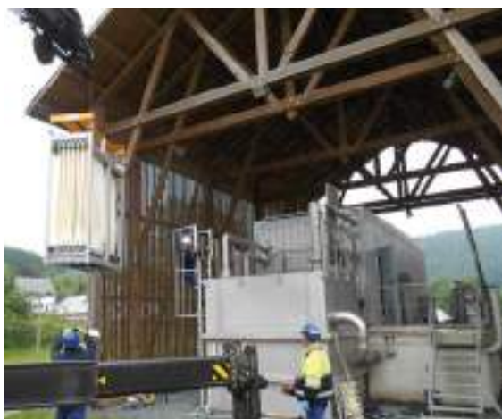
Vresse-sur-Semois // Opération de changement des membranes début 2019 par nos agents
