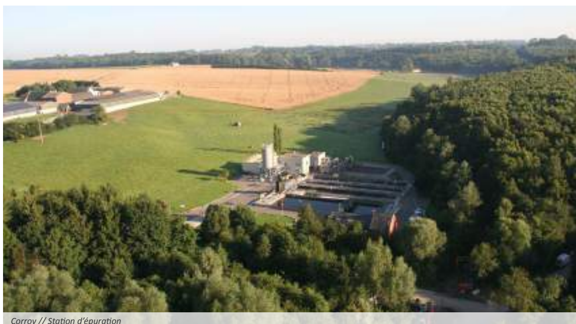
Corroy // Station d'épuration
