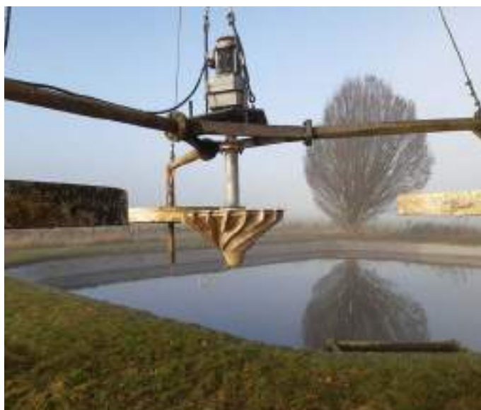
Saint-Denis // Remplacement de l'axe de la turbine d'aération de la lagune
