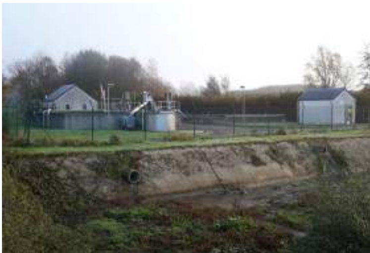
Les Isnes // Station d'épurations
