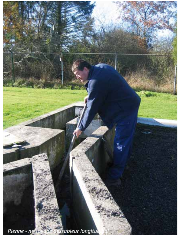
Rienne - nettoyage dessableur longitudinal
