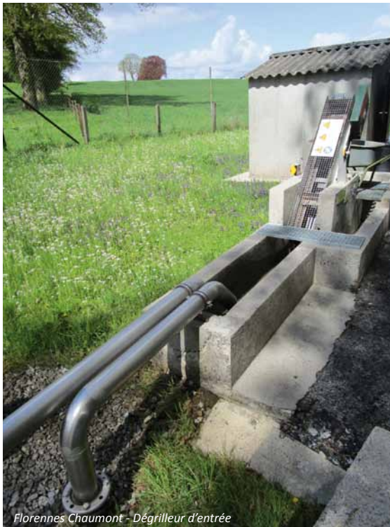
Florennes Chaumont - Dégrilleur d'entrée
