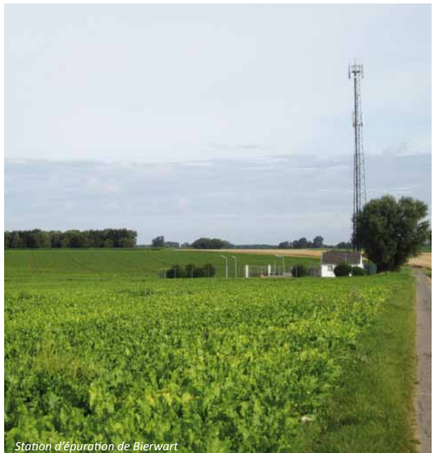
Station d'épuration de Bierwart
