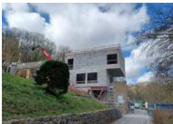
Rivière // Extension de l'école
