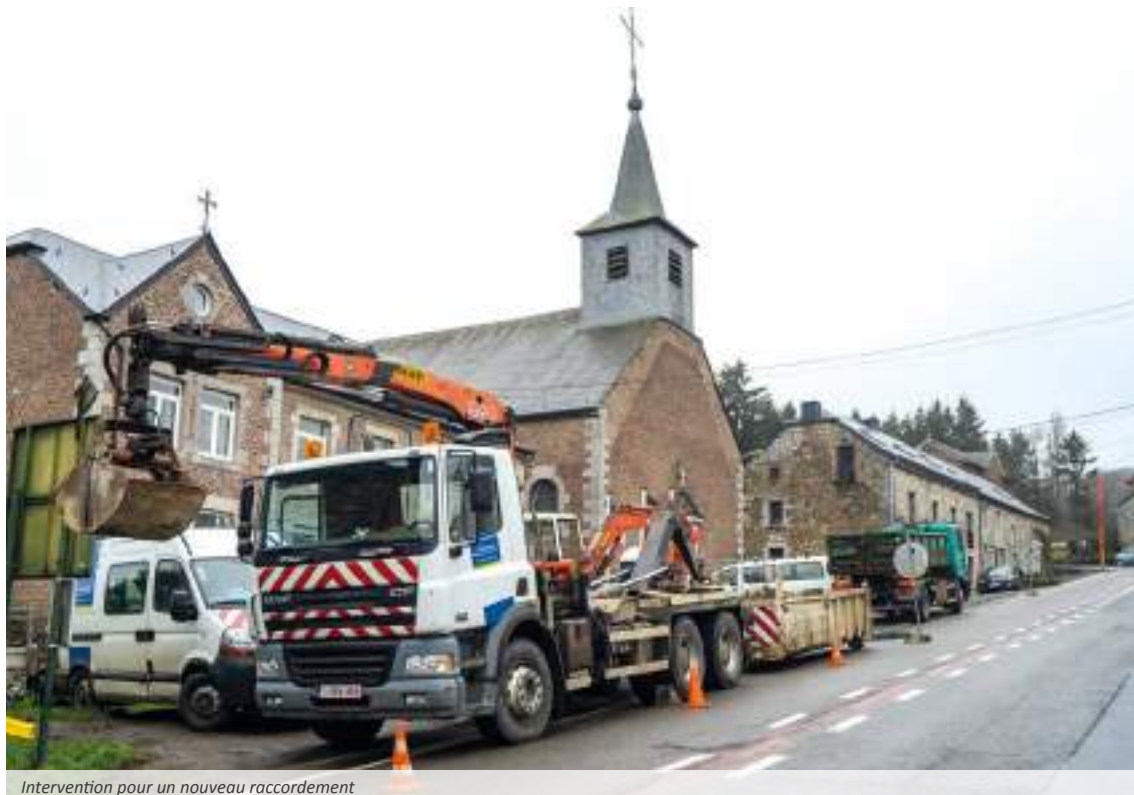
Intervention pour un nouveau raccordement
