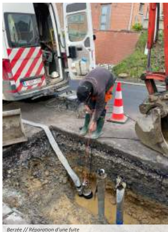
Berzée // Réparation d'une fuite
