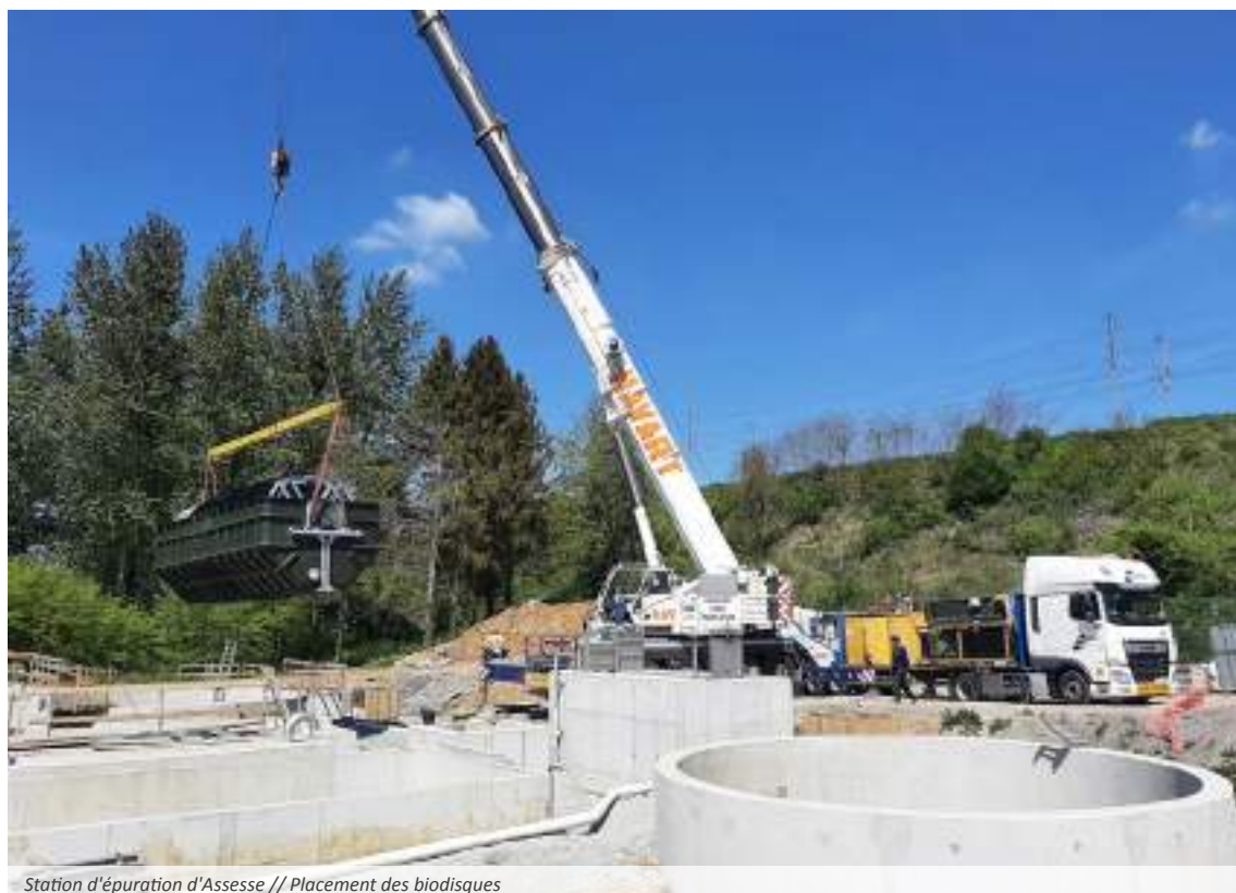
Station d'épuration d'Assesse // Placement des biodisques
