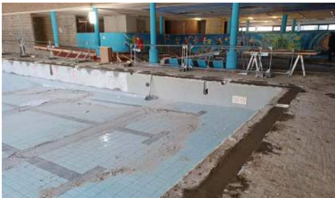
Auvelais // Rénovation de la piscine
