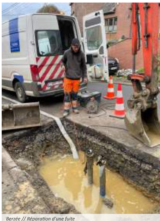
Berzée // Réparation d'une fuite
