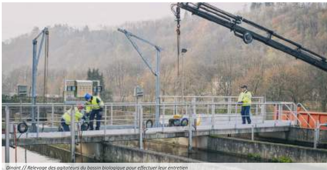
Dinant // Relevage des agitateurs du bassin biologique pour effectuer leur entretien
