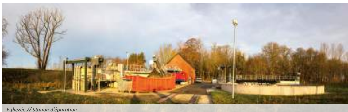
Eghezée // Station d'épuration
