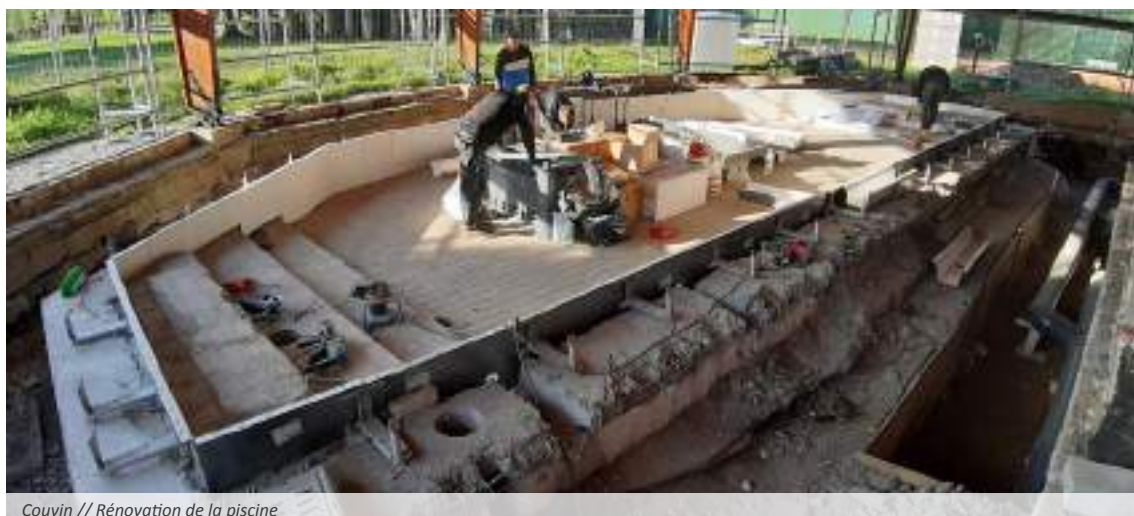
Couvin // Rénovation de la piscine
