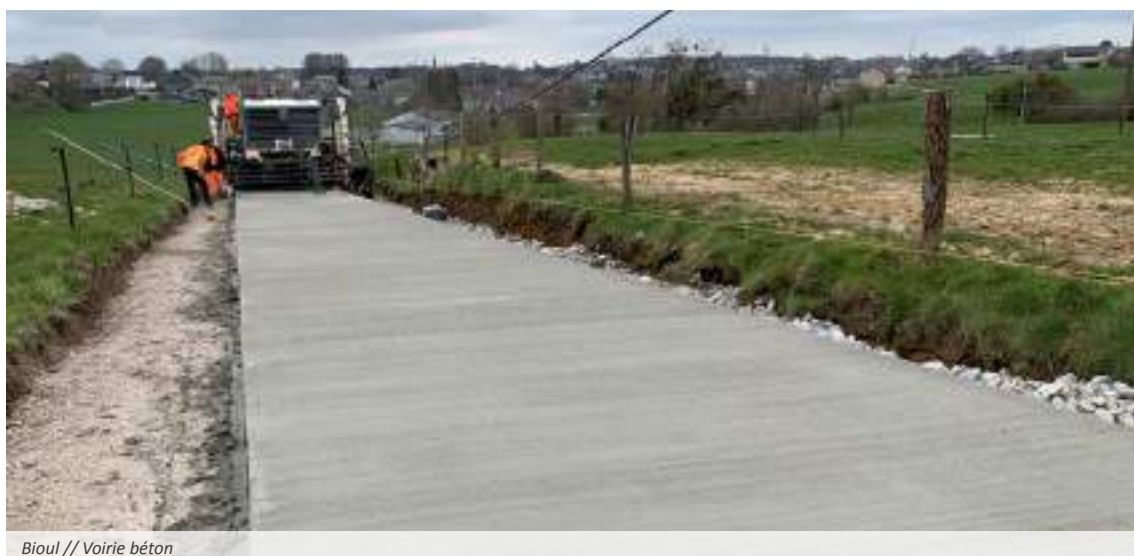
Bioul // Voirie béton
