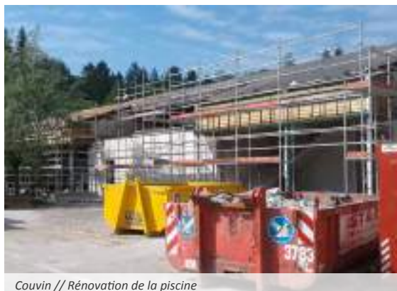
Couvin // Rénovation de la piscine
