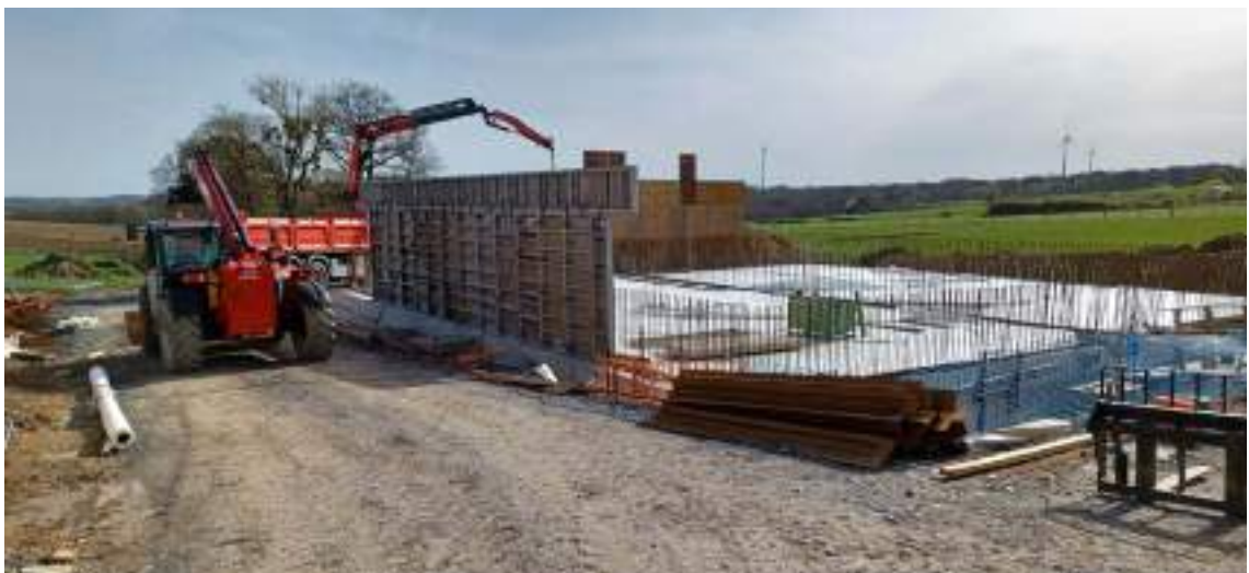
Adduction Est // Réservoir de Blaimont // Coffrage et ferrailage voiles réservoir
