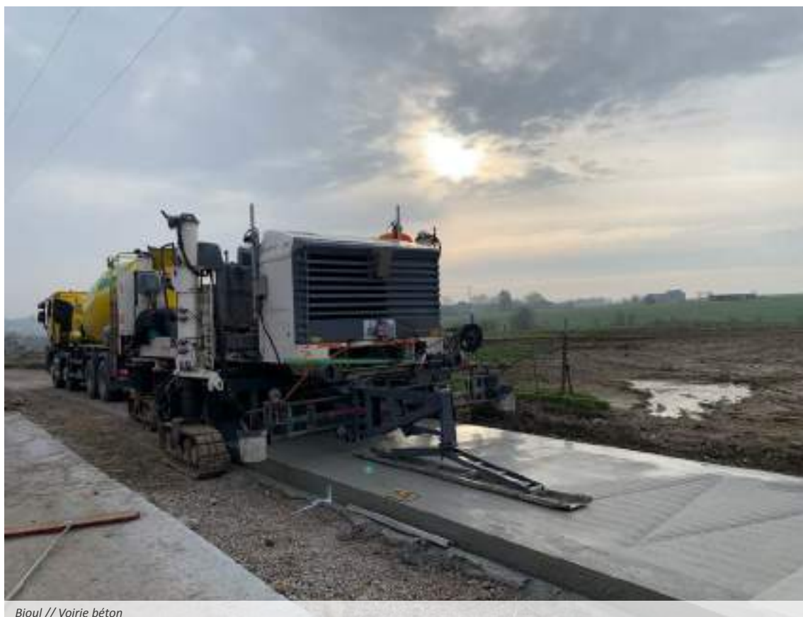
Bioul // Voirie béton
