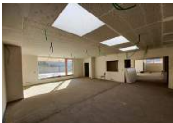
Patignies // Chantier VBO
