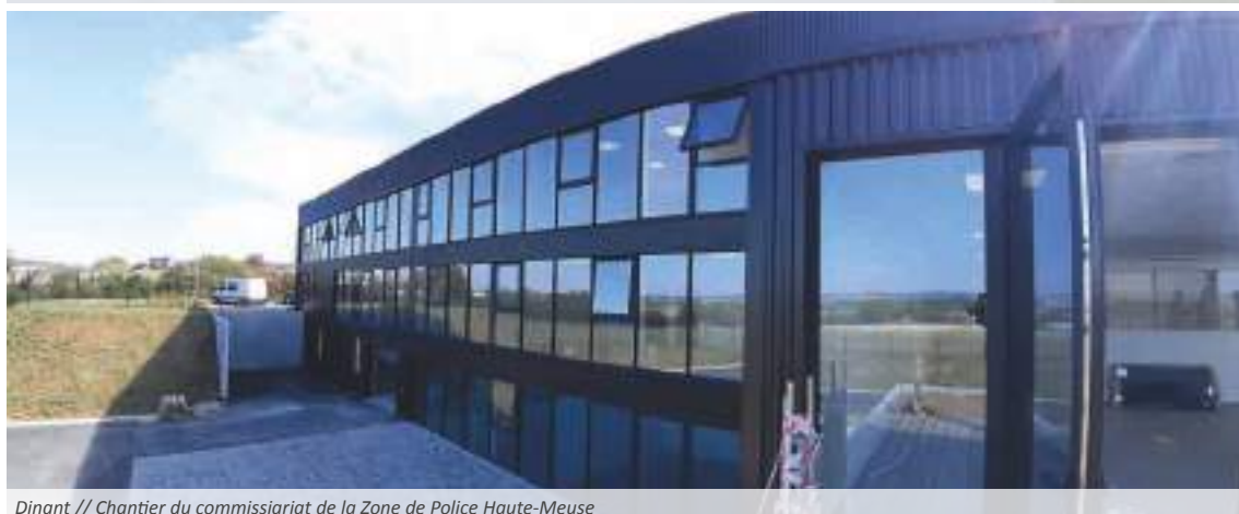
Dinant // Chantier du commissariat de la Zone de Police Haute-Meuse
