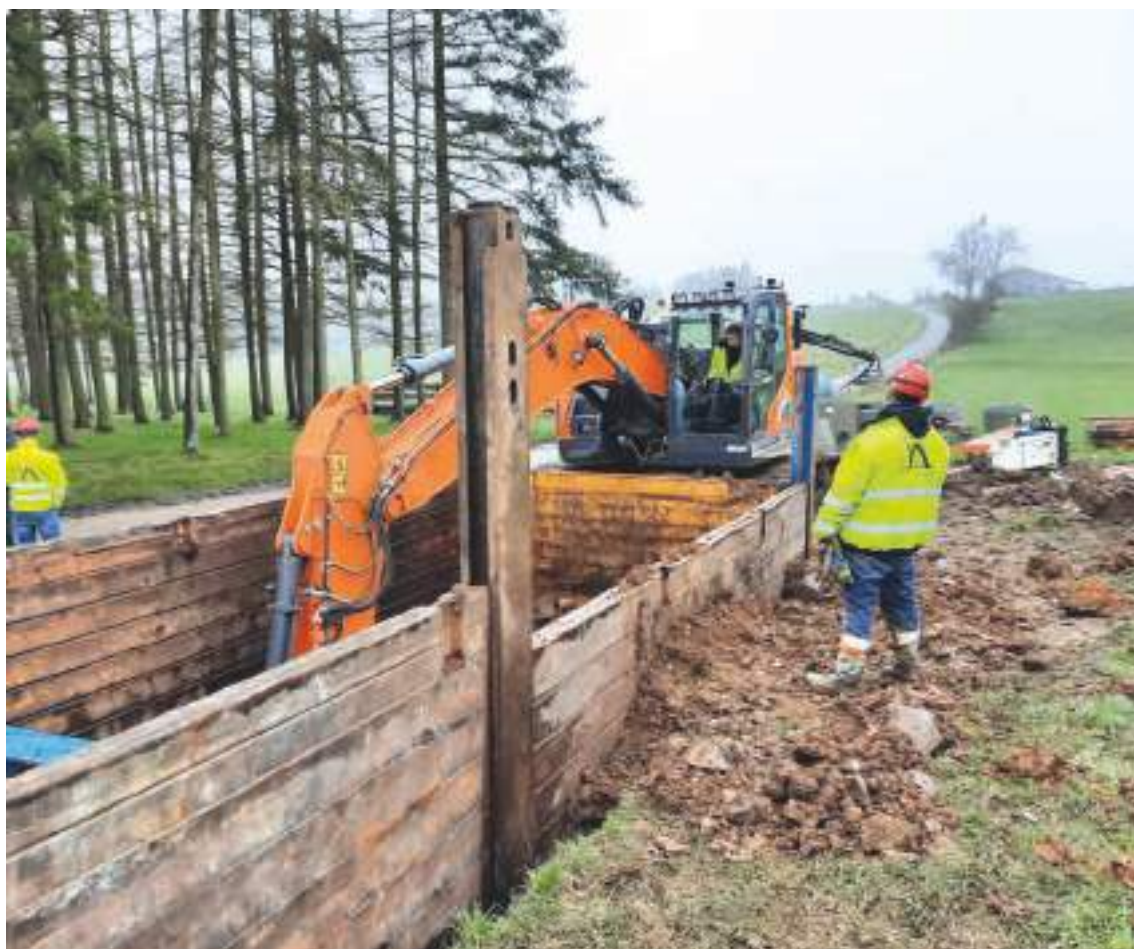
Sorinnes // Rénovation de la voirie et de l'égouttage rue Marot
