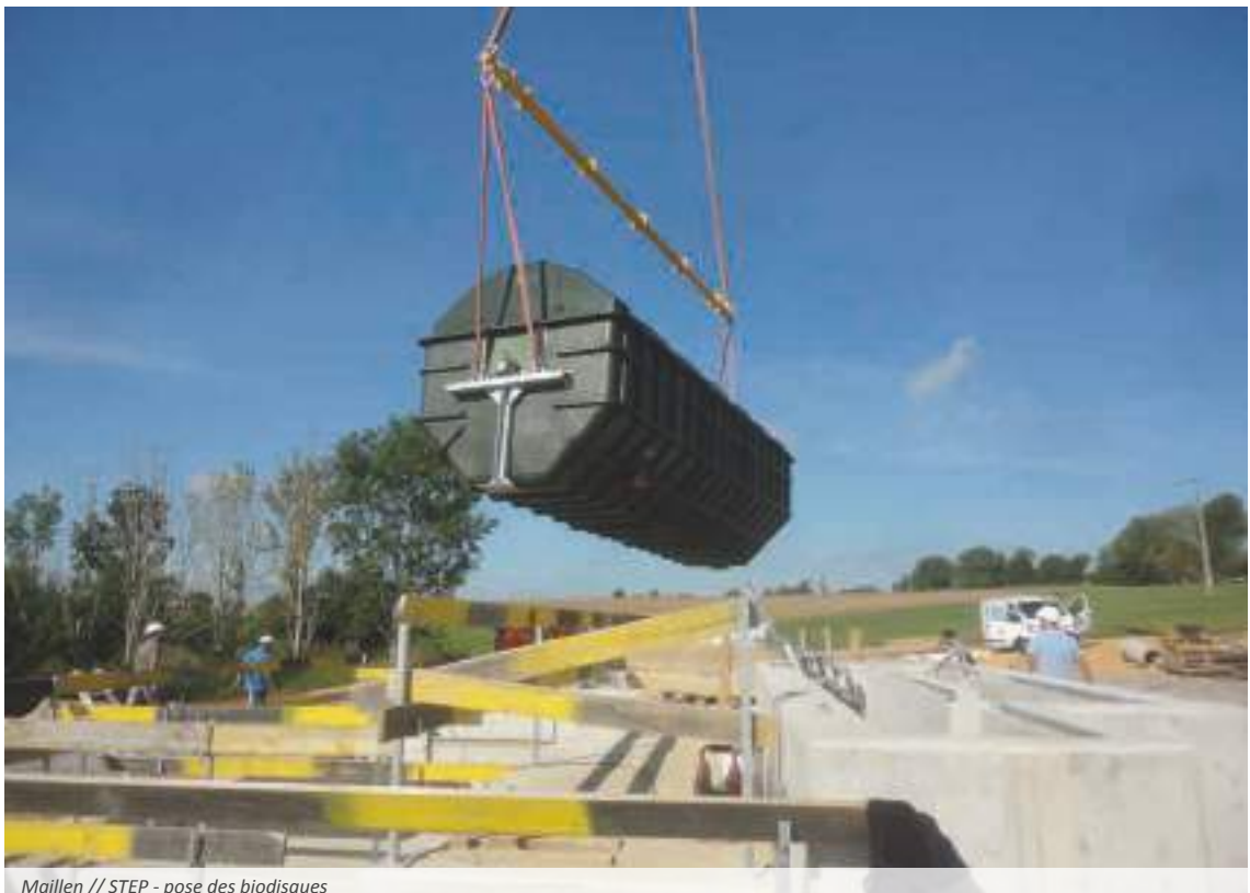
Maillen // STEP - pose des biodisques
