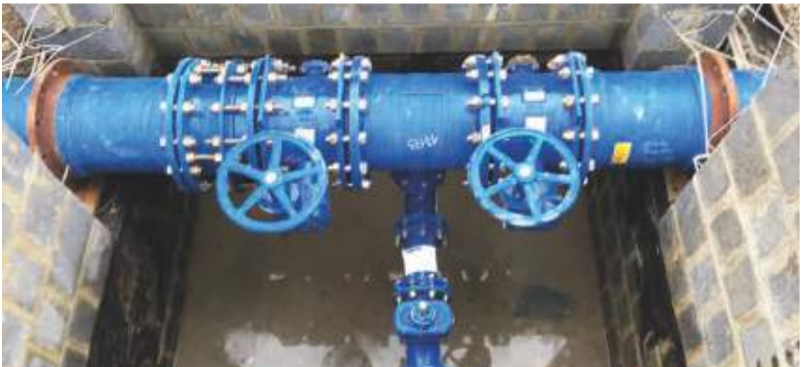
Chambre de visite du chantier de l'autoroute de l'eau
