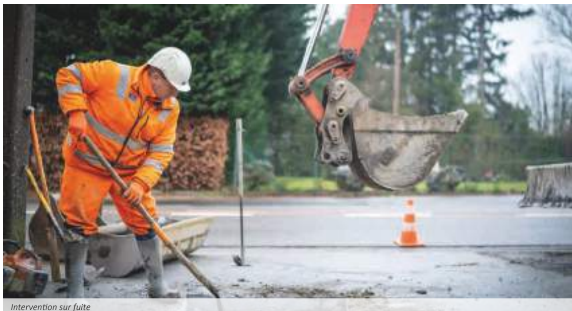
Intervention sur fuite
