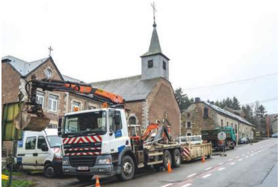
Intervention pour un nouveau raccordement
