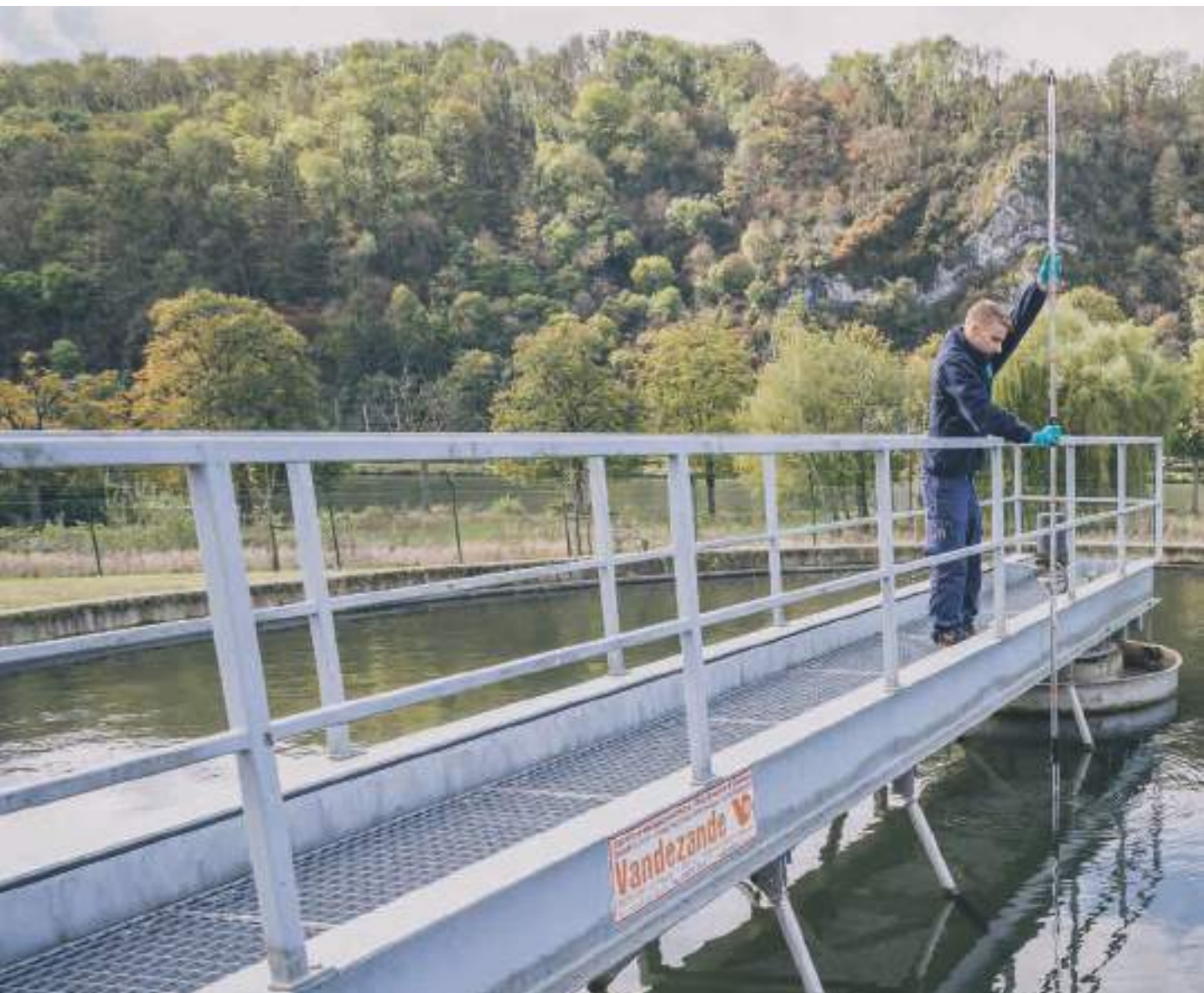
Dinant // Station d'épuration
