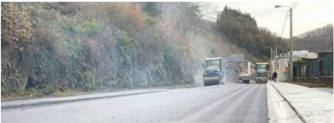
Hastière // Pose hydro 2 finisseuses
