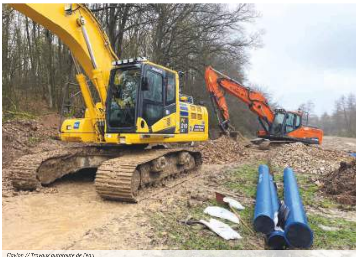
Flavion // Travaux autoroute de l'eau
