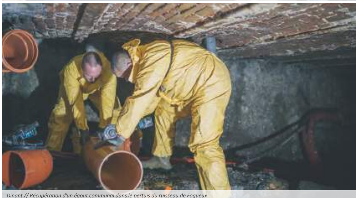
Dinant // Récupération d'un égout communal dans le pertuis du ruisseau de Foqueux
