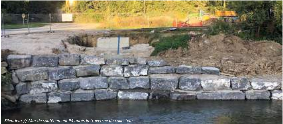
Silenrieux // Mur de soutènement P4 après la traversée du collecteur
