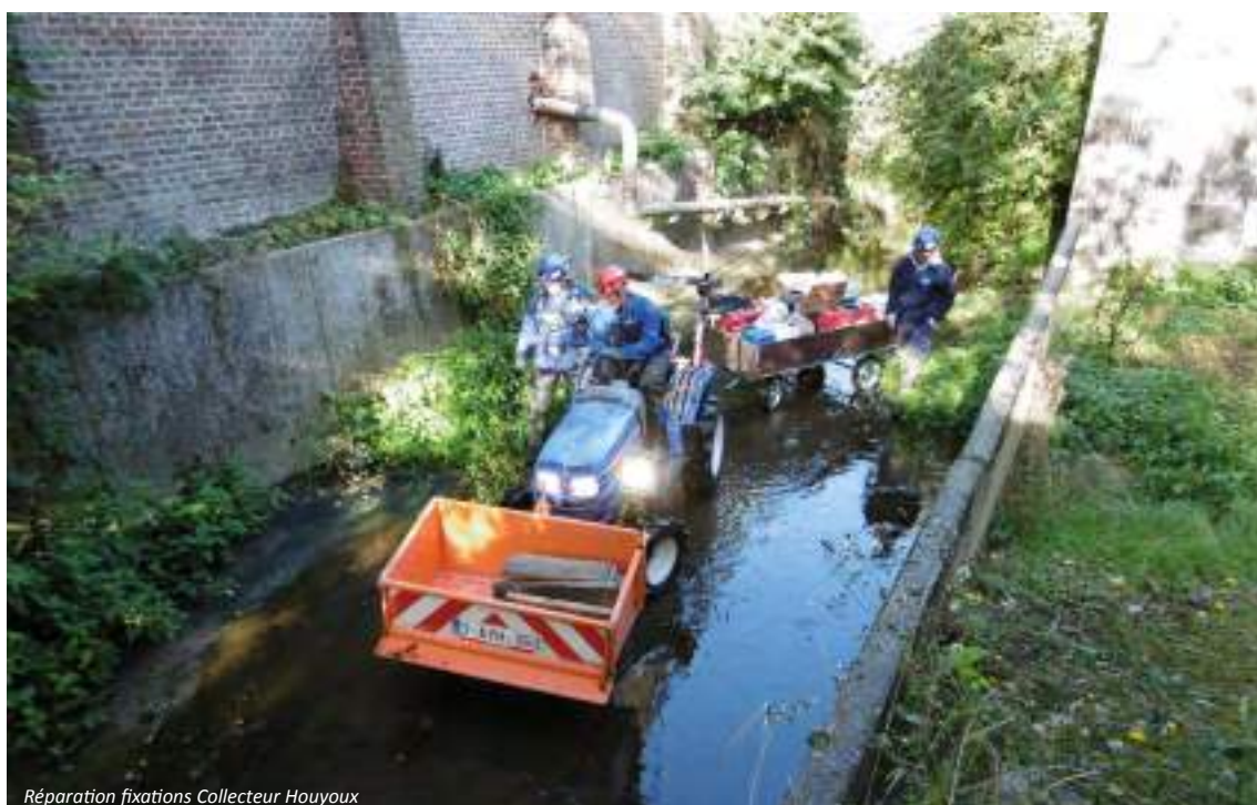
Réparation fixations Collecteur Houyoux
