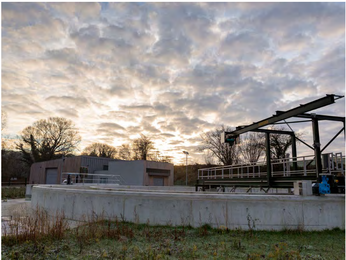
Fosses-la-Ville // Station d'épuration
