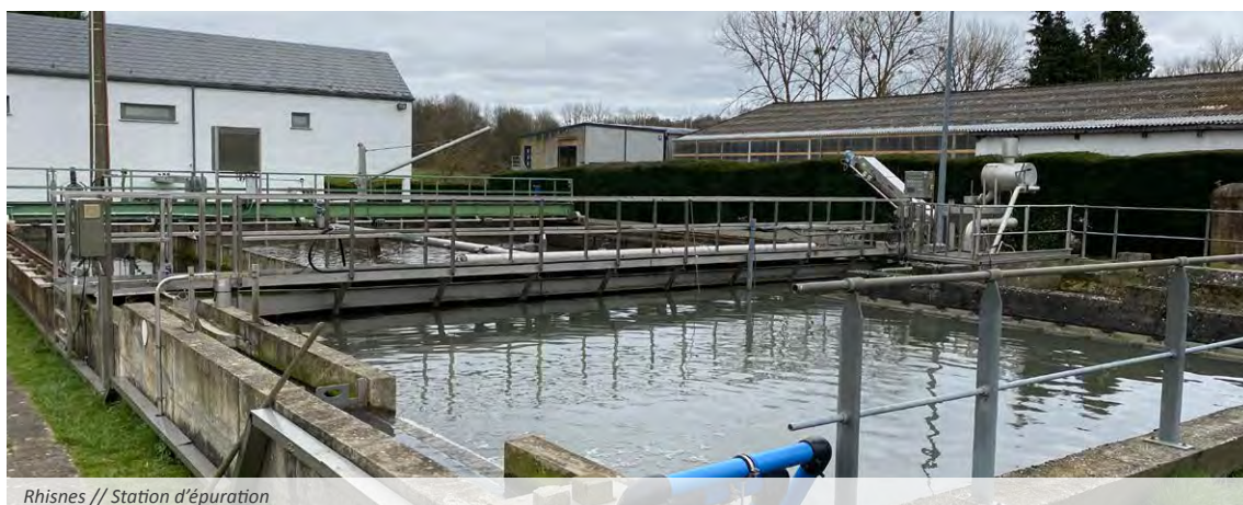
Rhisnes // Station d'épuration
