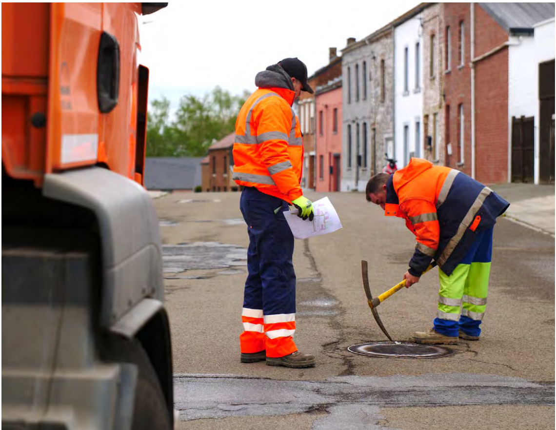
Curage de réseaux d'égouttage par une société spécialisée, au moyen d'une hydrocureuse
