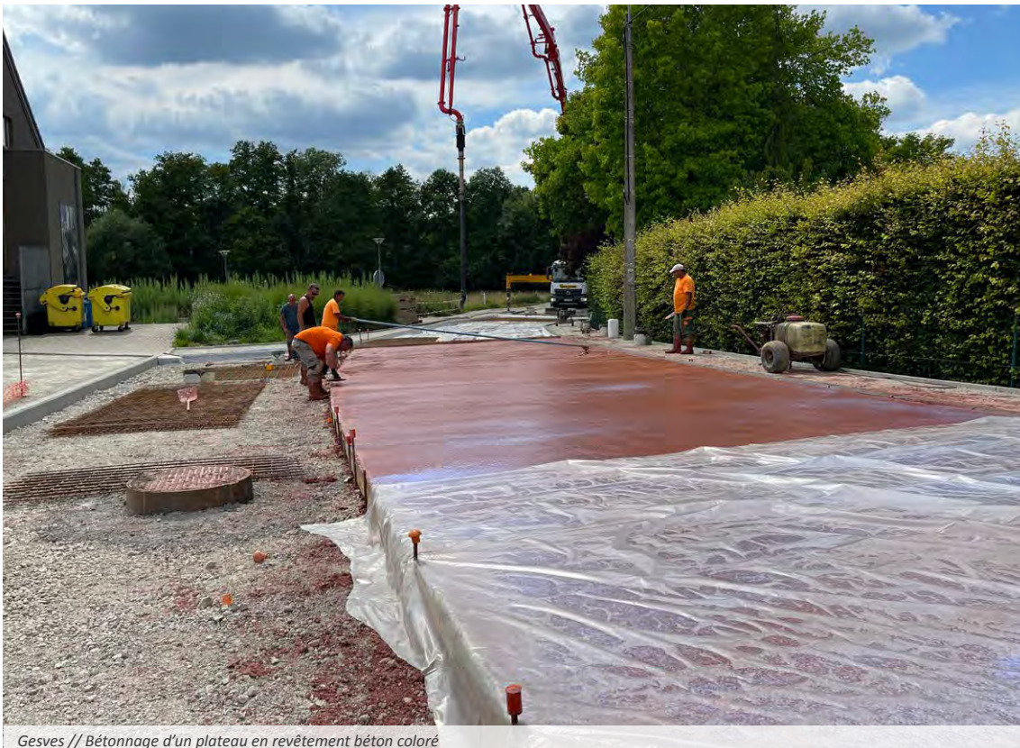
Gesves // Bétonnage d'un plateau en revêtement béton coloré
