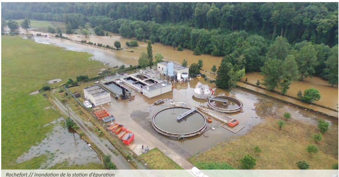
Rochefort // Inondation de la station d'épuration
