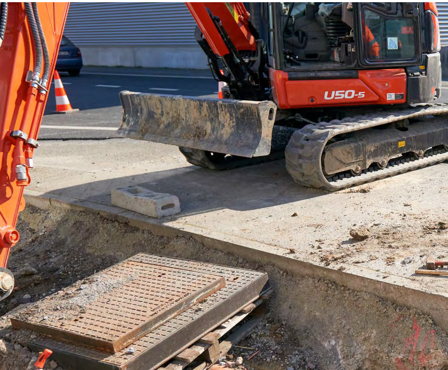
Intervention sur fuite
