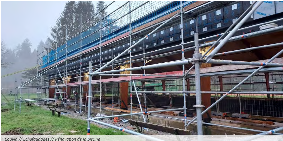
Couvin // Echafaudages // Rénovation de la piscine
