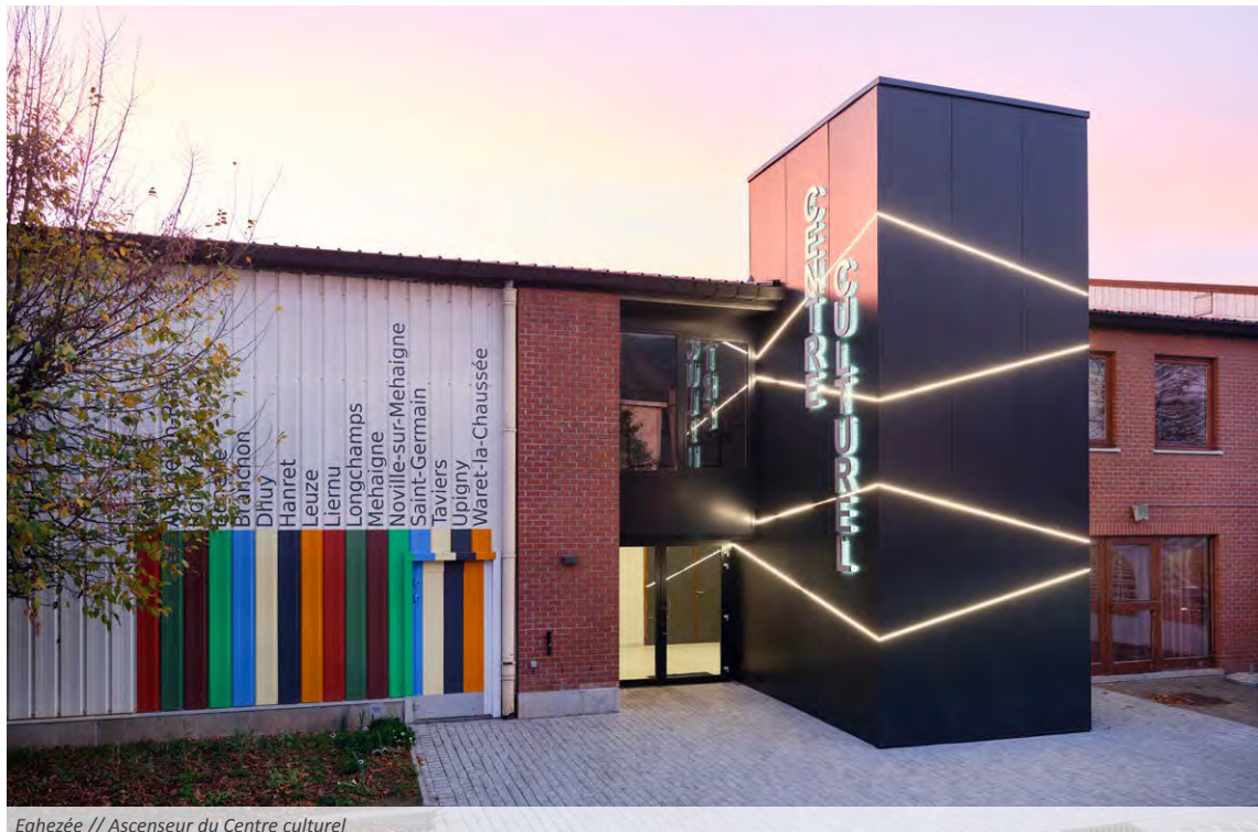
Eghezée // Ascenseur du Centre culturel
