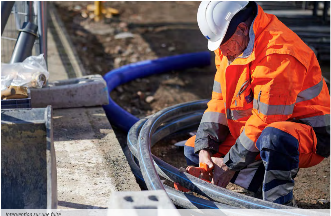
Intervention sur une fuite
