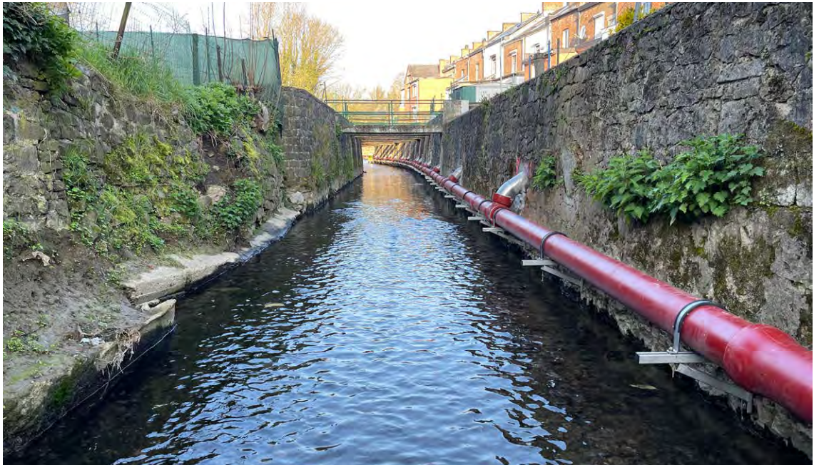
Saint-Servais // Pose de canalisation dans le Houyoux
