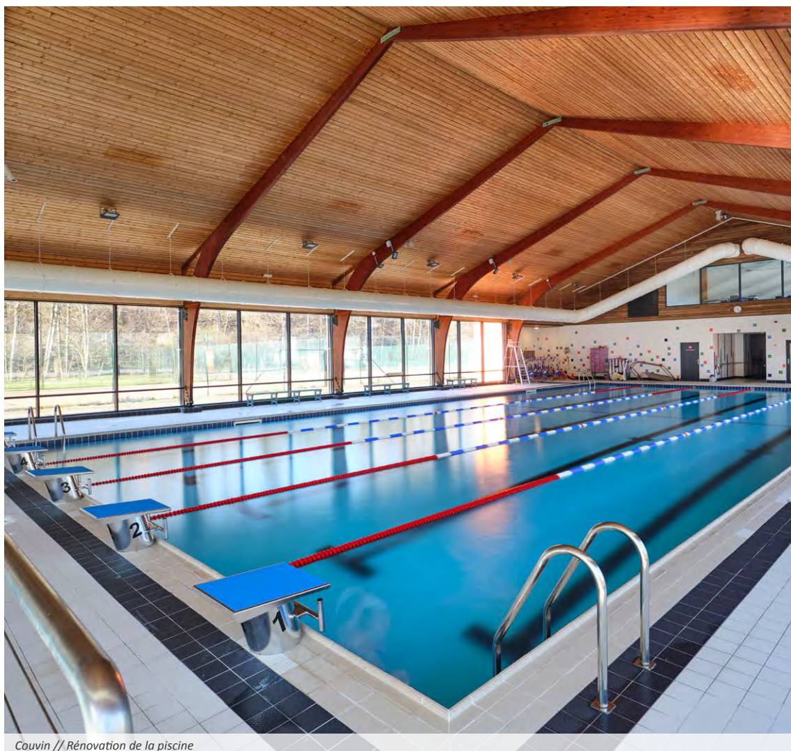
Couvin // Rénovation de la piscine
