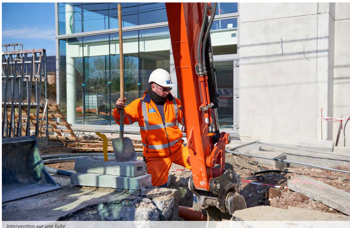
Intervention sur une fuite
