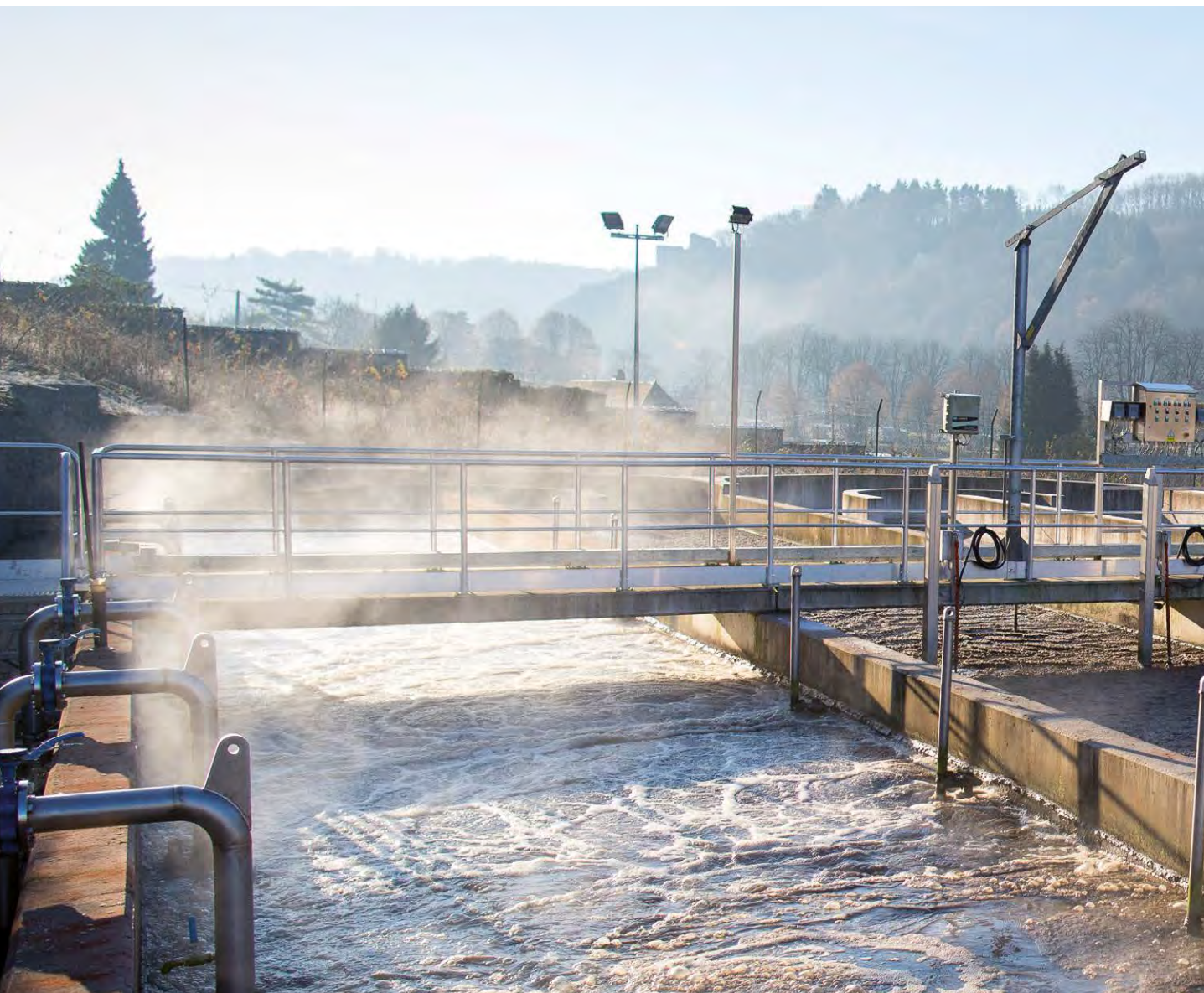
Dinant // Station d'épuration
