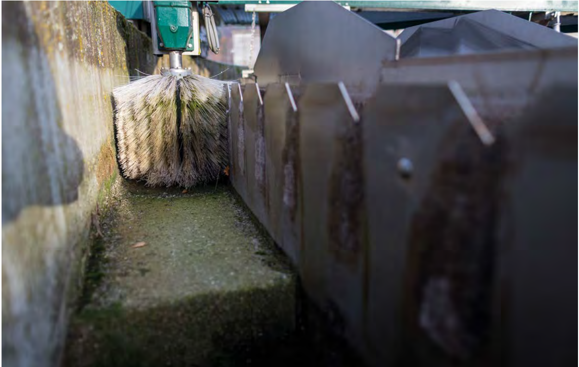
Floreffe // Nettoyage de la goulotte du clarificateur
