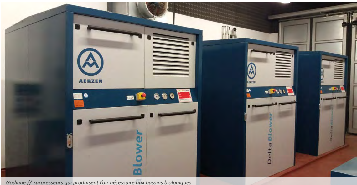
Godinne // Surpresseurs qui produisent l'air nécessaire aux bassins biologiques
