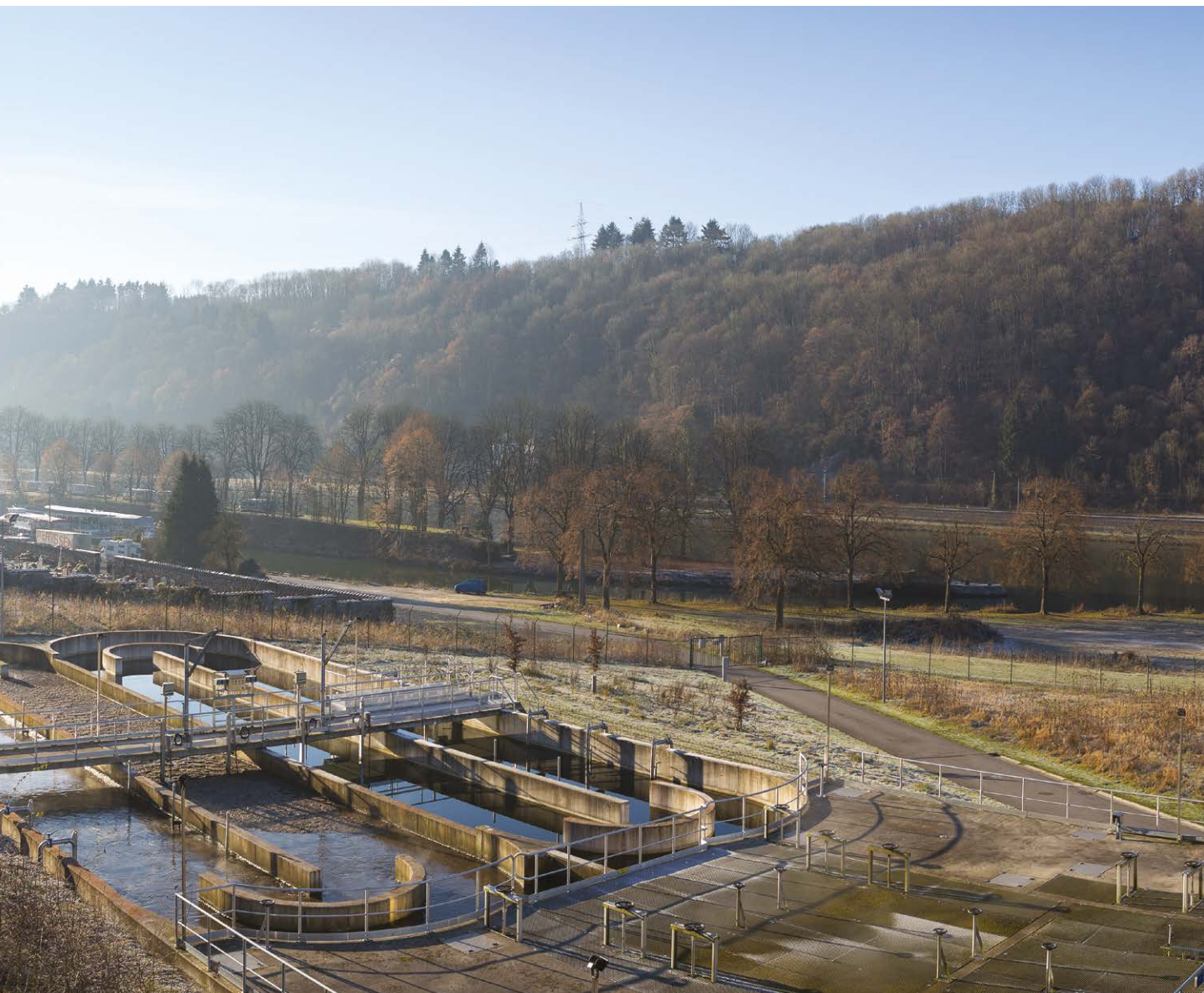
Dinant // Station d'épuration
