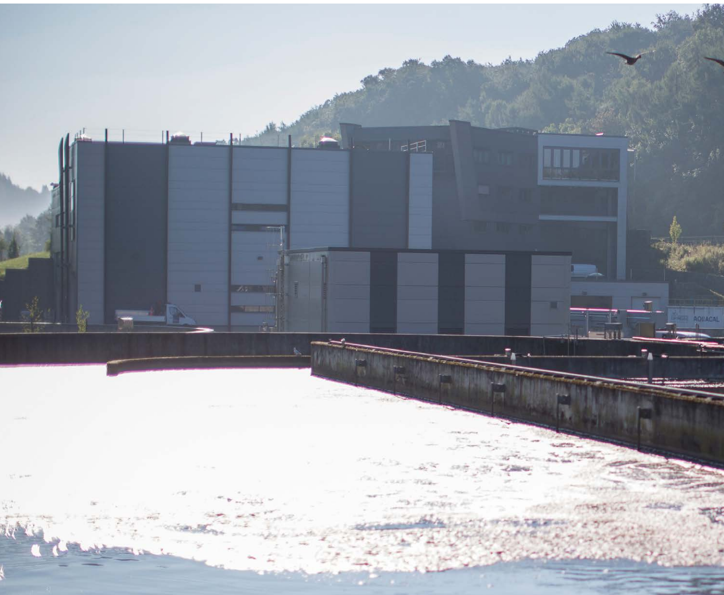
Lives-sur-Meuse // Station d'épuration
