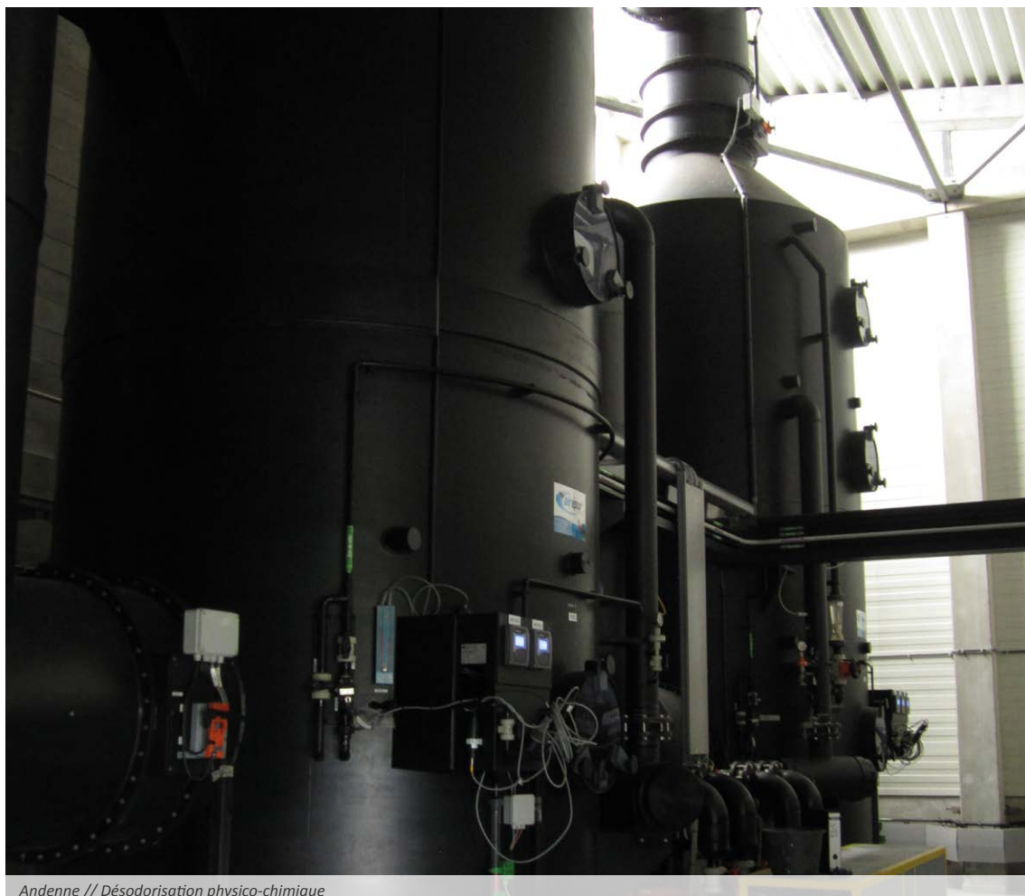
Andenne // Désodorisation physico-chimique
