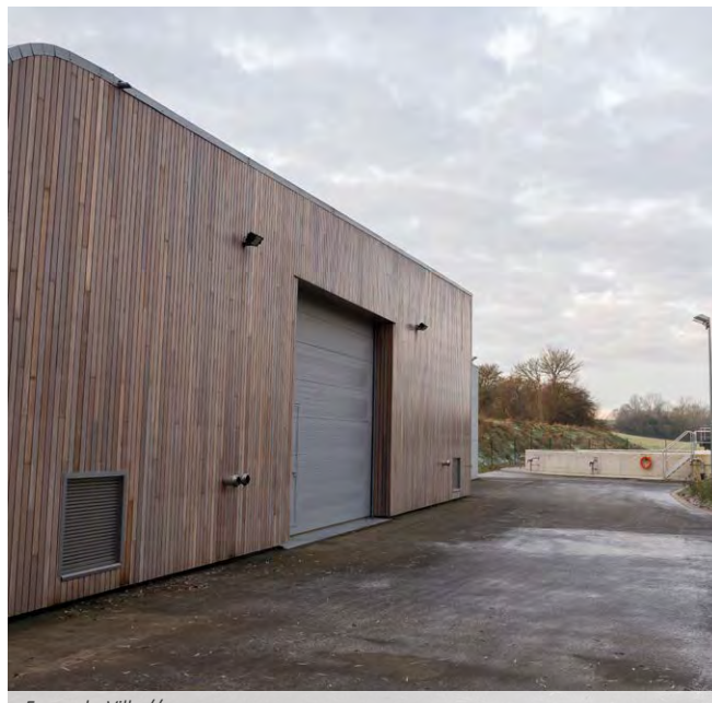
Fosses-la-Ville // Intégration paysagère et couverture de l'unité malodorante de prétraitement
