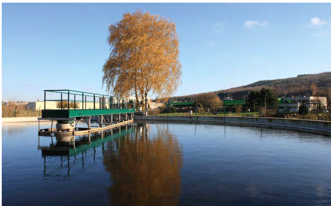
Floreffe // Décanteur secondaire (eaux traitées avant rejet)
