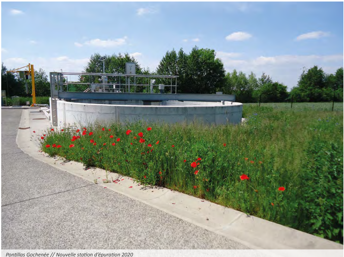
Pontillas Gochenée // Nouvelle station d'épuration 2020
