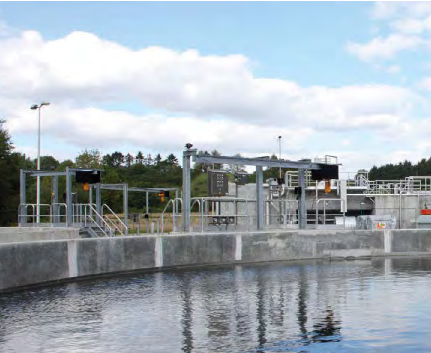
Saint-Martin // Station d'épuration
