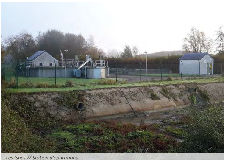
Les Isnes // Station d'épurations
