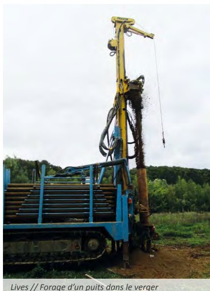
Lives // Forage d'un puits dans le verger
