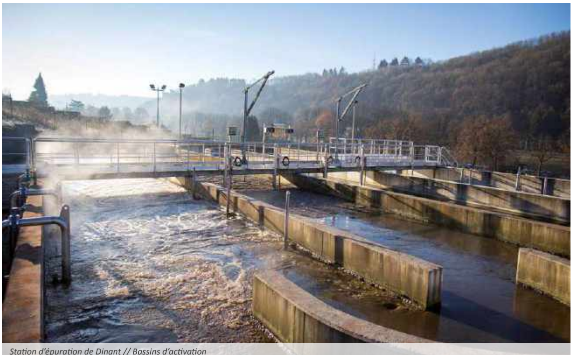
Station d'épuration de Dinant // Bassins d'activation
