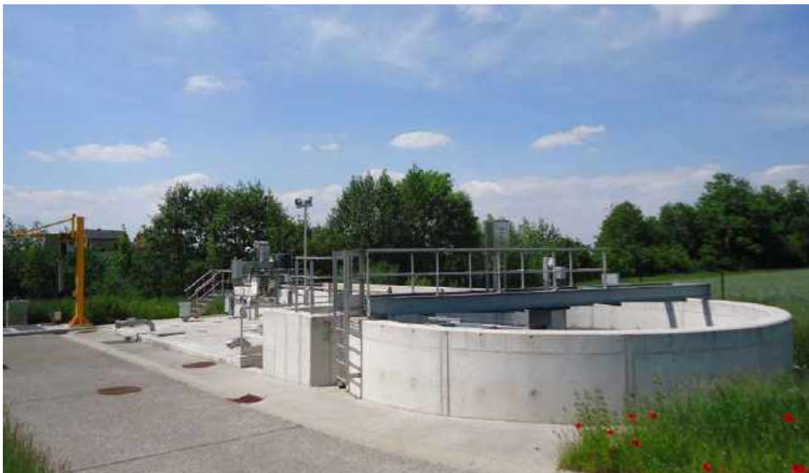
Pontillas Gochenée // Nouvelle station d'épuration
