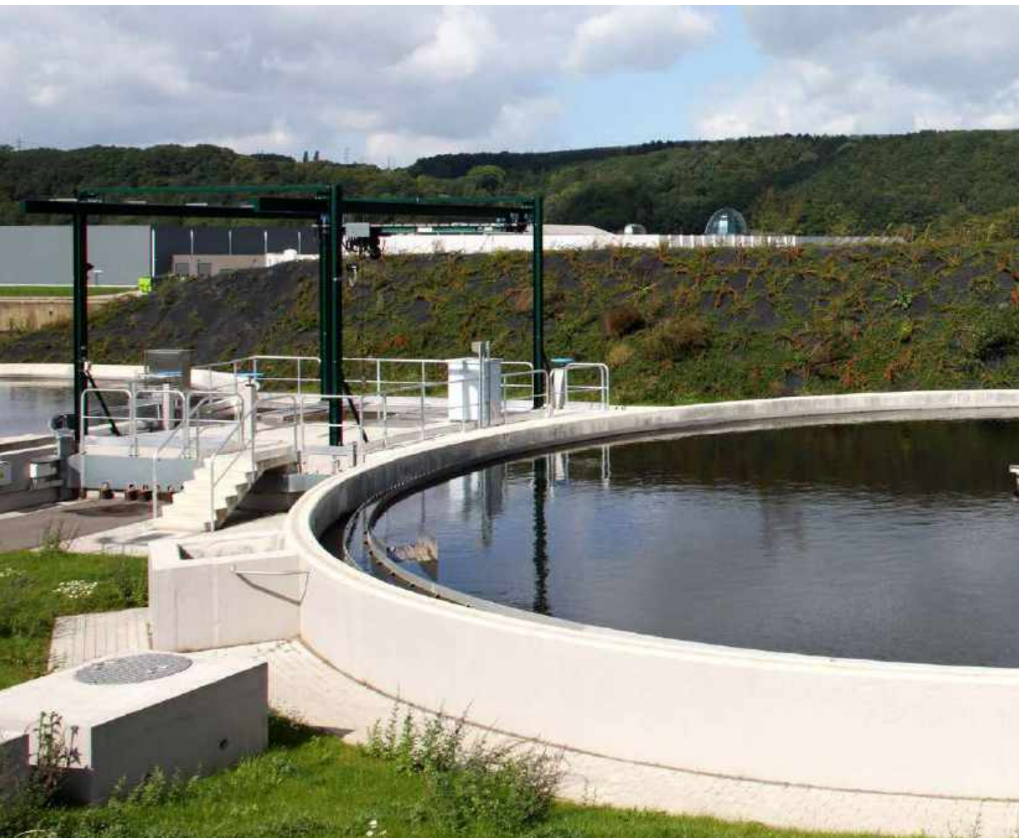
Andenne // Décanteur secondaire
