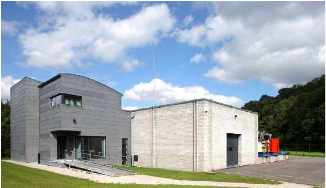
Saint-Martin // Bâtiment de la station d'épuration
