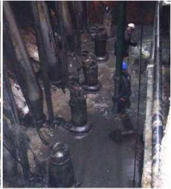
Tournée Namur // Curage de la station de pompage SP17 des Grands Malades
