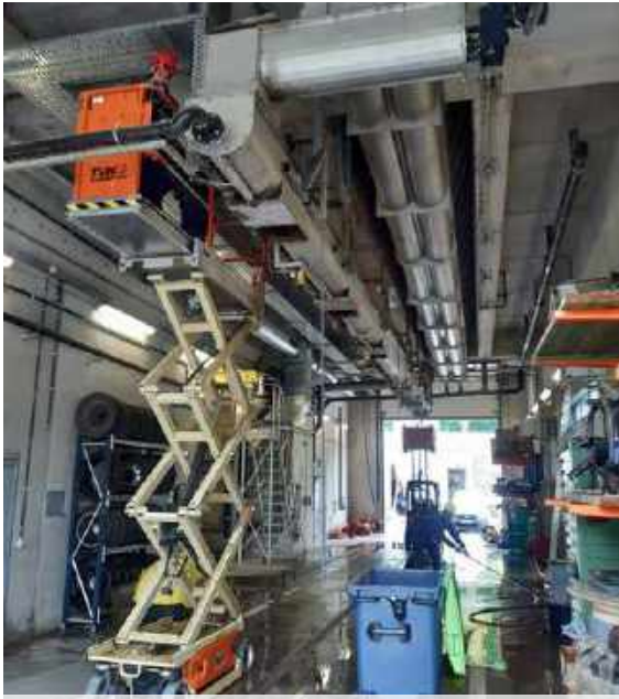
Lives // Travail en hauteur : remplacement du revêtement d'usure de la vis à boues
