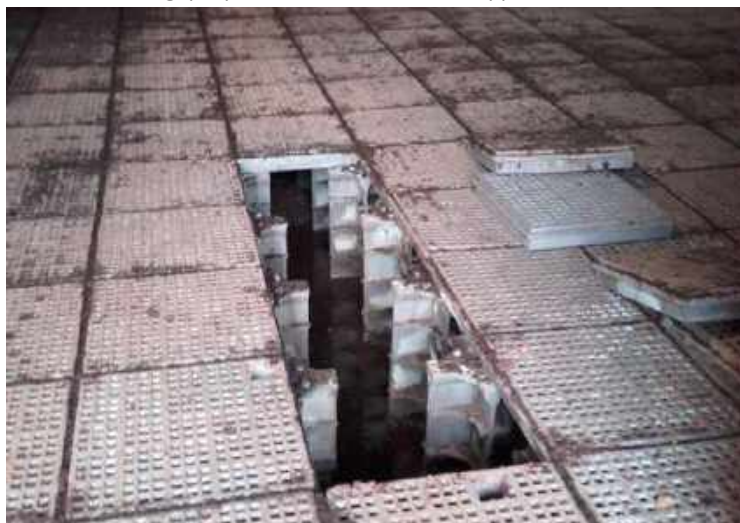
Lèves // Changement des copeaux de la désodorisation biologique
