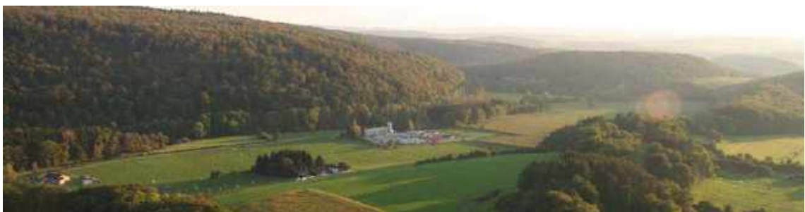
Rochefort // Vue aérienne de la station d'épuration
