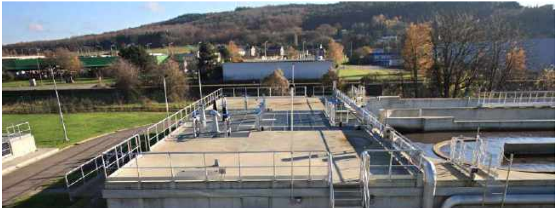
Station d'épuration de Floreffe / Zone de déphosphoration
