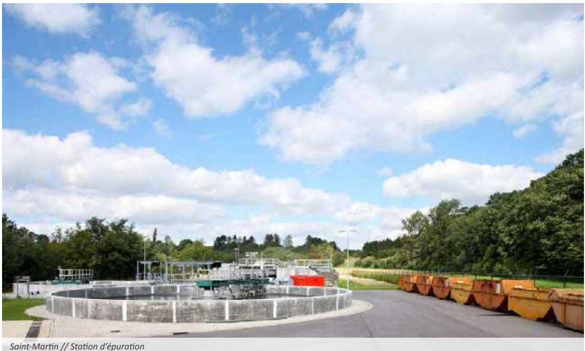
Saint-Martin // Station d'épuration
