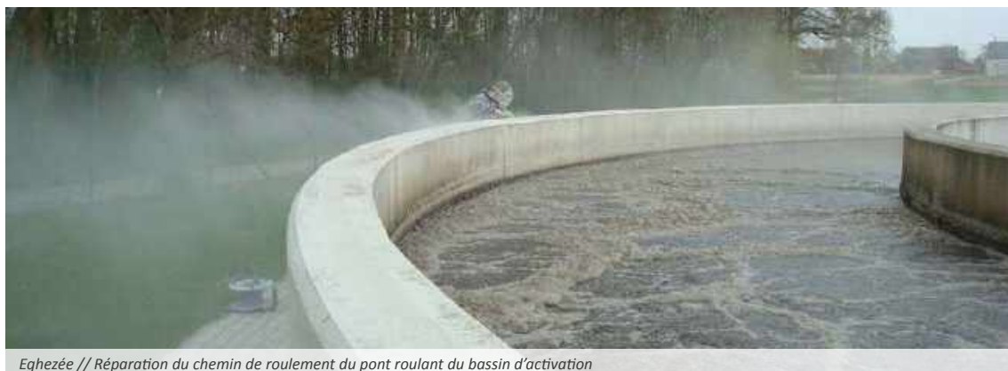
Eghezée // Réparation du chemin de roulement du pont roulant du bassin d'activation
