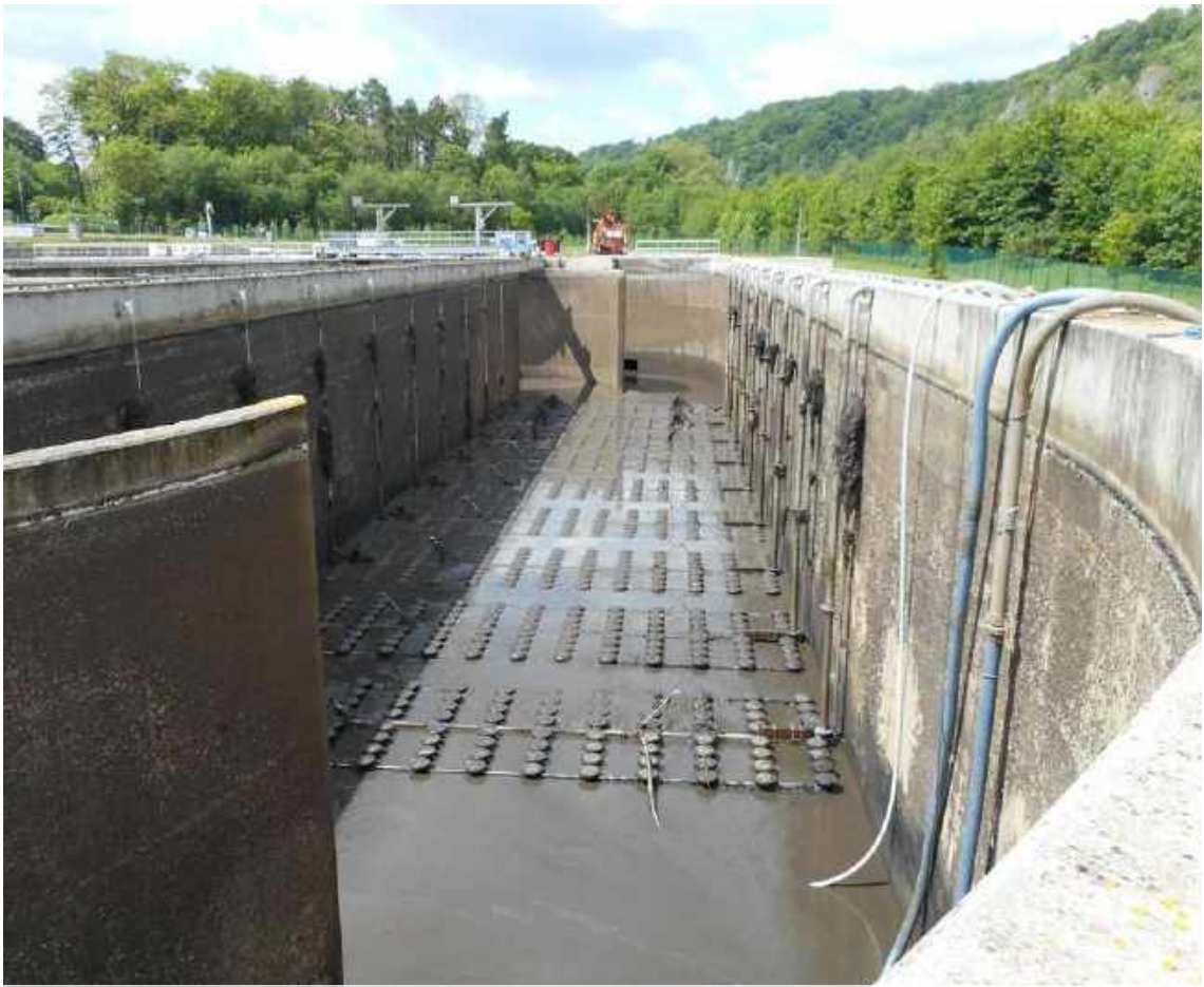
Lives // Nettoyage des diffuseurs d'air des bassins d'activation
