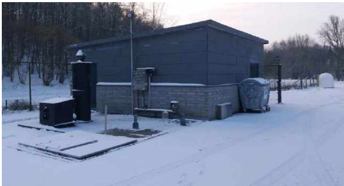
St-Martin // Unité de dépotage de gadoues et sa tour de désodorisation
