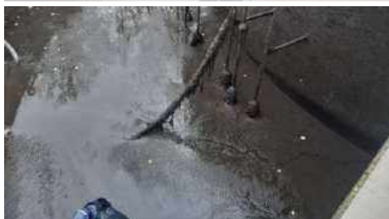
Florennes Saint-Aubin // Arrêt complet de la station pour vider le bassin d'activation et remplacer l'accélérateur de courant et les diffuseurs d'air
