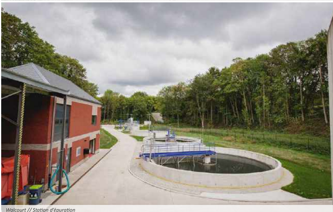
Walcourt // Station d'épuration
