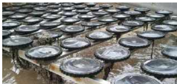
Corroy-le-Château // Intervention sur les rampes d'aération
