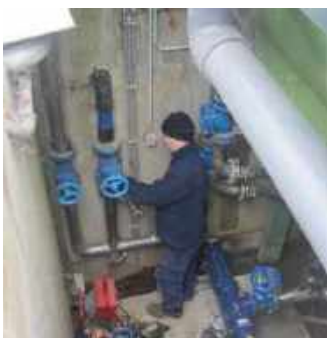
Soumoy // Intervention de la maintenance sur la recirculation
