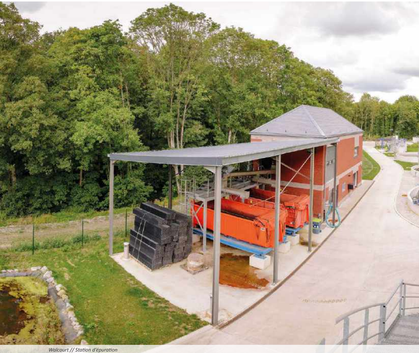
Walcourt // Station d'épuration
