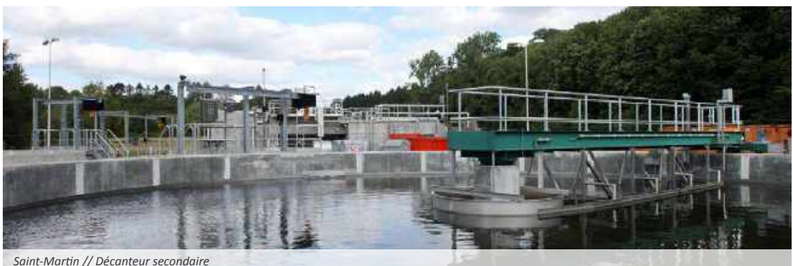
Saint-Martin // Décanteur secondaire
