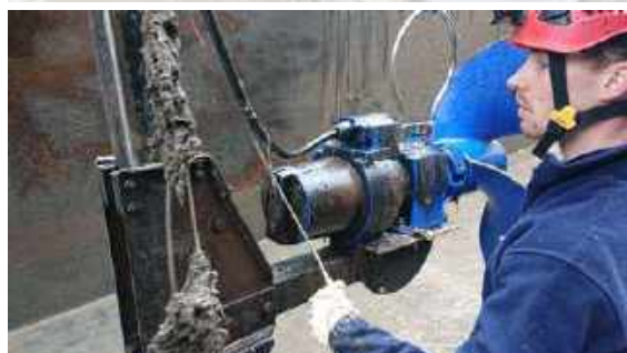
Gelbressée // Curage du bassin biologique
