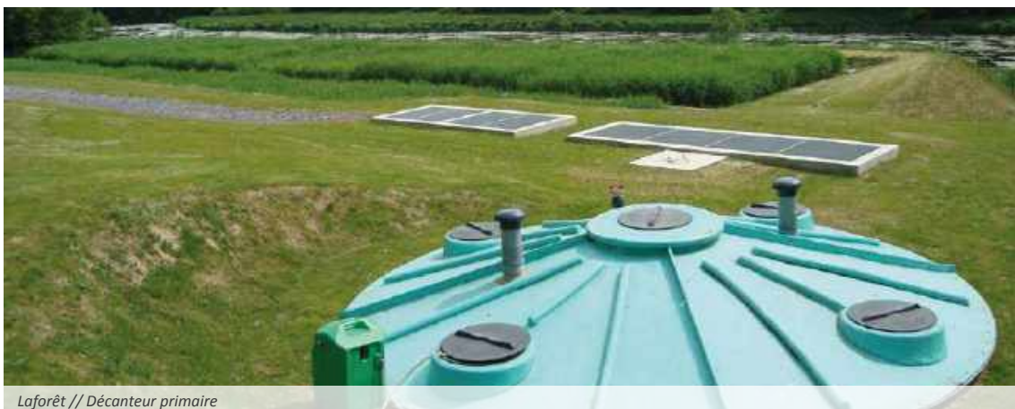
Laforêt // Décanteur primaire
