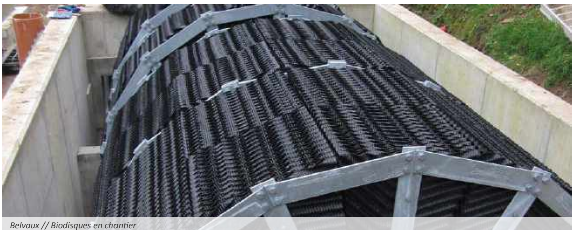
Belvaux // Biodisques en chantier
