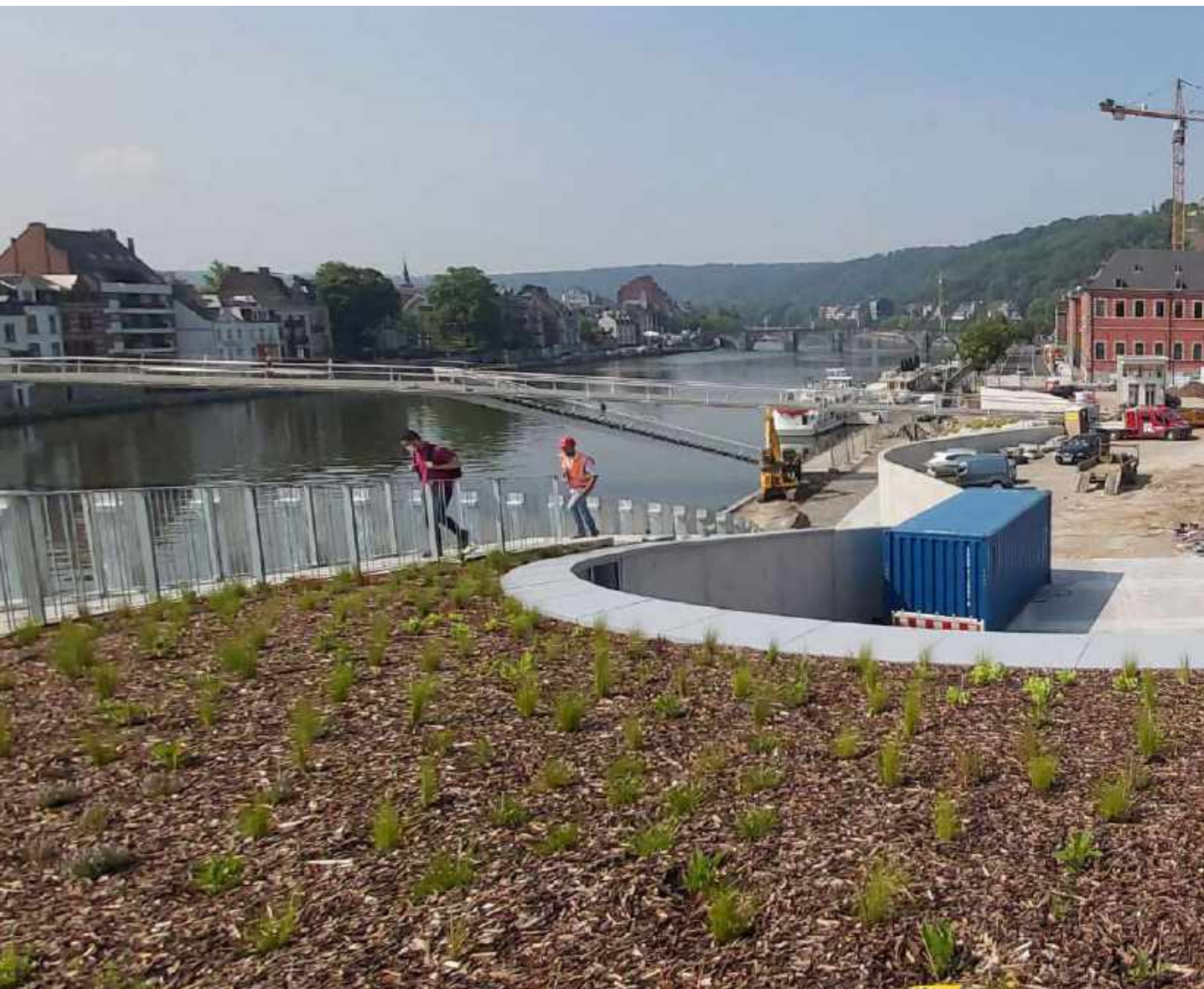
Namur // Coordination sur le chantier de l'Esplanade du Grognon
