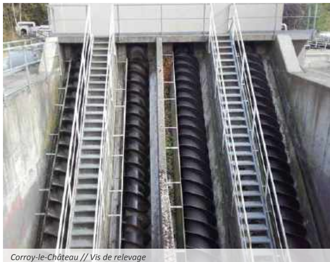
Corroy-le-Château // Vis de relevage
