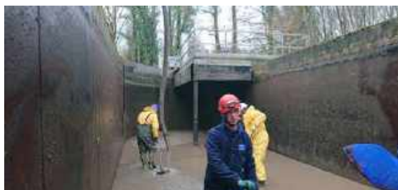
Gelbressée // Curage du bassin biologique
