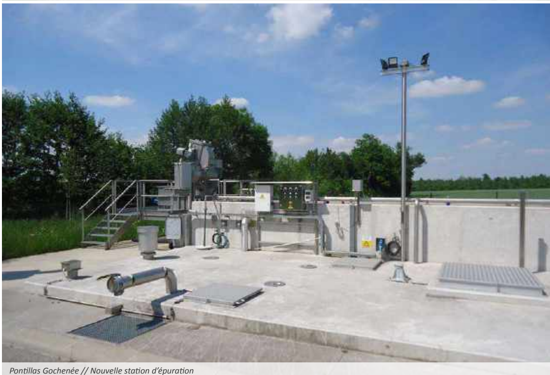
Pontillas Gochenée // Nouvelle station d'épuration
